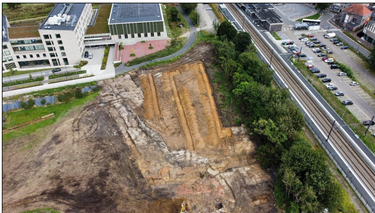
Figuur 27: Dronefoto van de werkputten (centraal) en de diep gesaneerde zone (onderaan).
