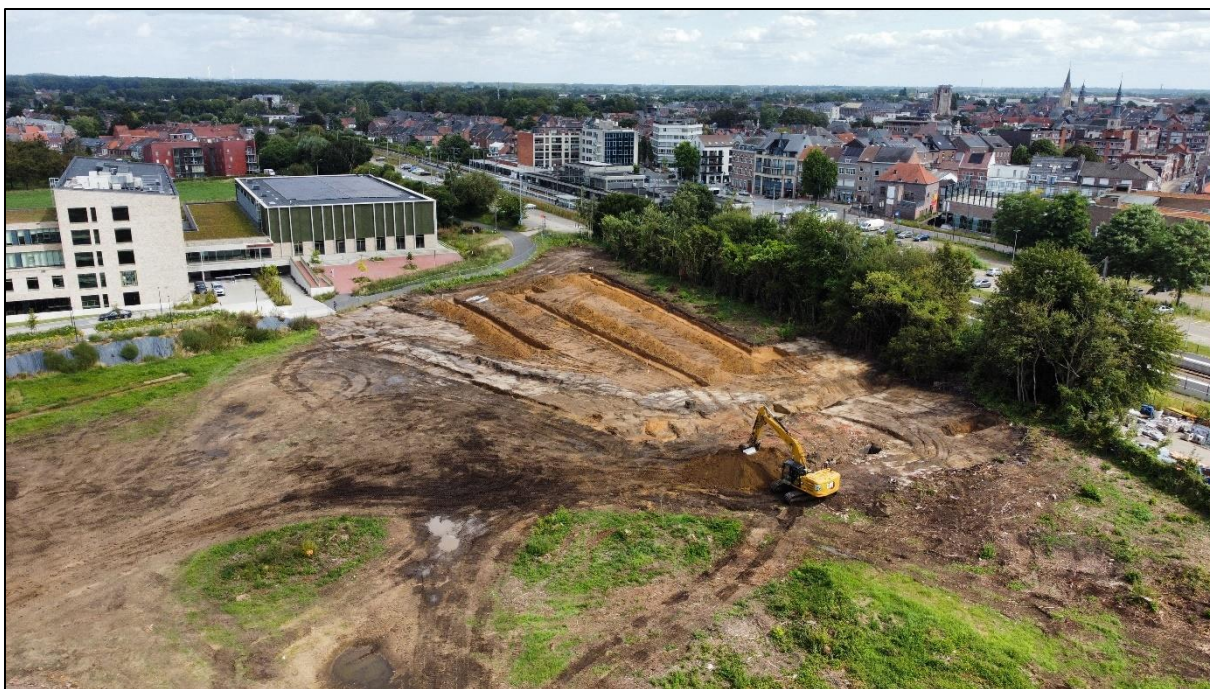
Figuur 10: Dronefoto van de werkputten en de sanering.
