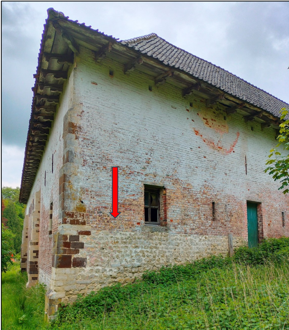
Figuur 85: Algemeen zicht op de noordelijke hoek van het haakse stalgebouw met ouder bouwkundig relict in kalkzandsteen (ABO nv 2024)
