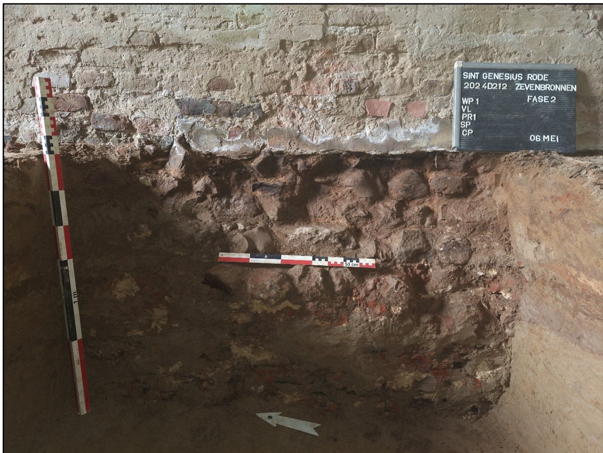
Figuur 80: Detail van de fundering van de oostelijke zijgevel (ABO nv 2024)
