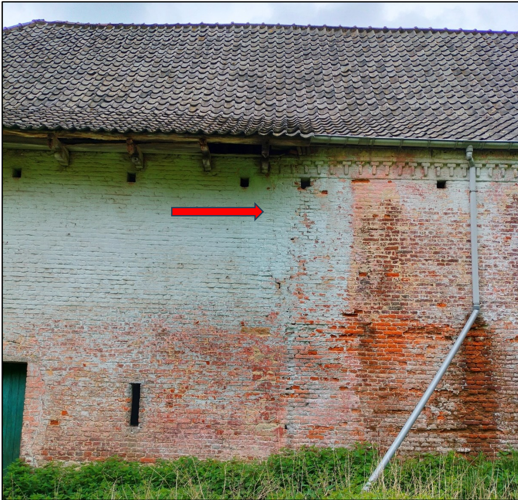
Figuur 84: Bouwnaad aan de veldzijde tussen beide stalgebouwen (ABO nv 2024)
