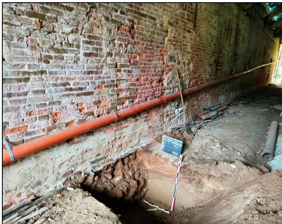
Figuur 79: Situering van proefput 1 ter hoogte van de oostelijke zijgevel (ABO nv 2024)
