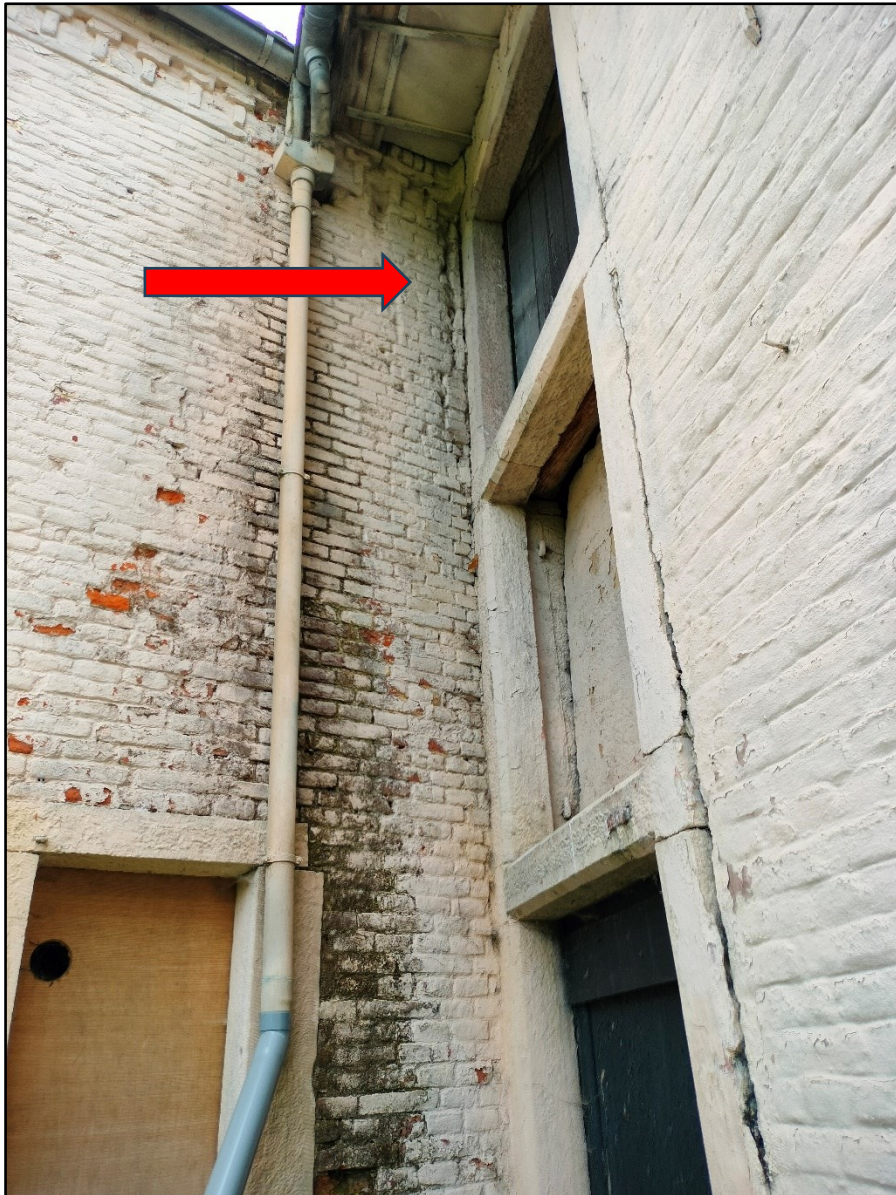
Figuur 83: Bouwnaad aan de erfzijde tussen beide stalgebouwen (ABO nv 2024)
