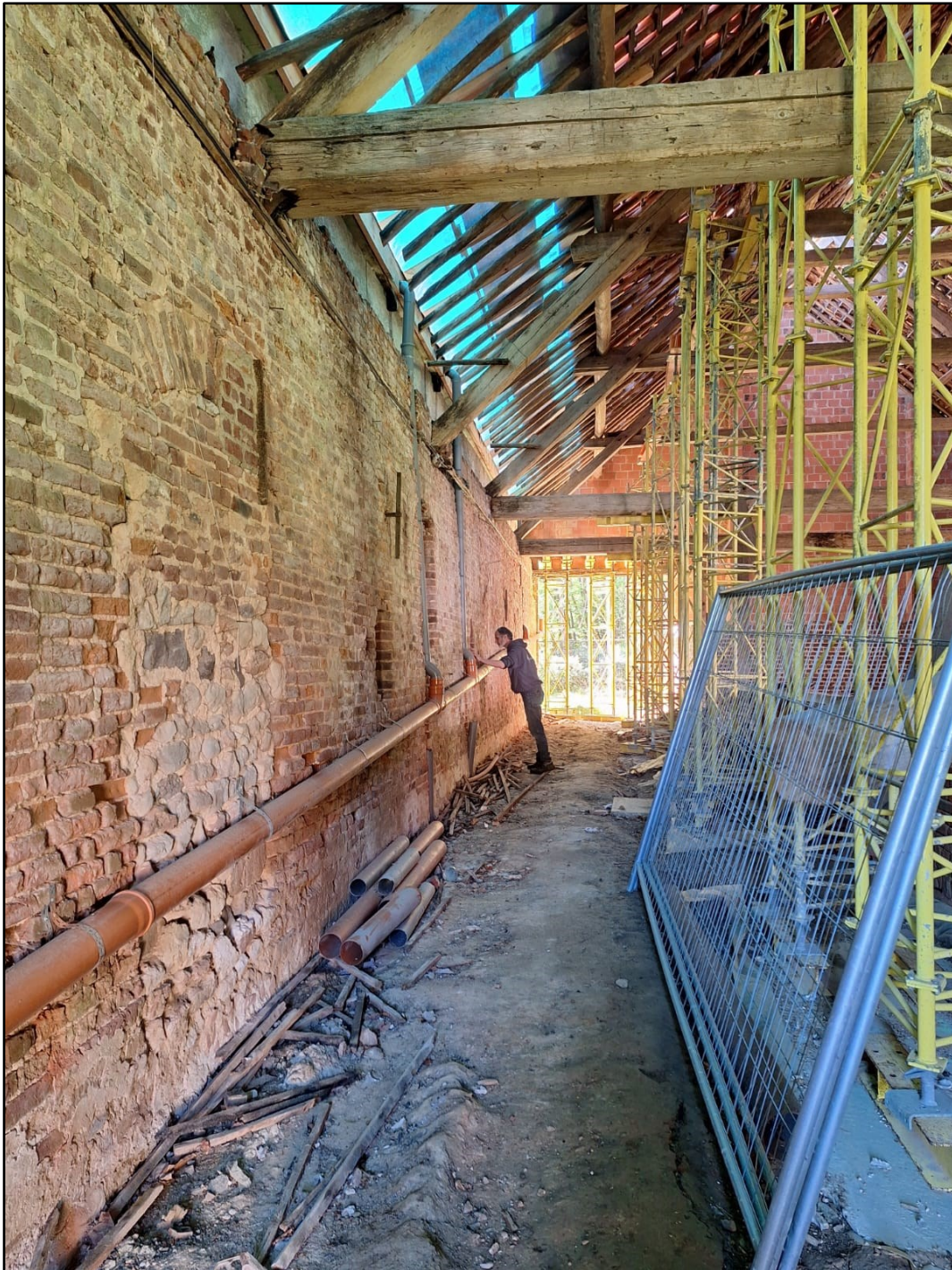
Figuur 76: Algemeen zicht op de oostelijke zijgevel van de langsschuur (ABO nv 2024)
