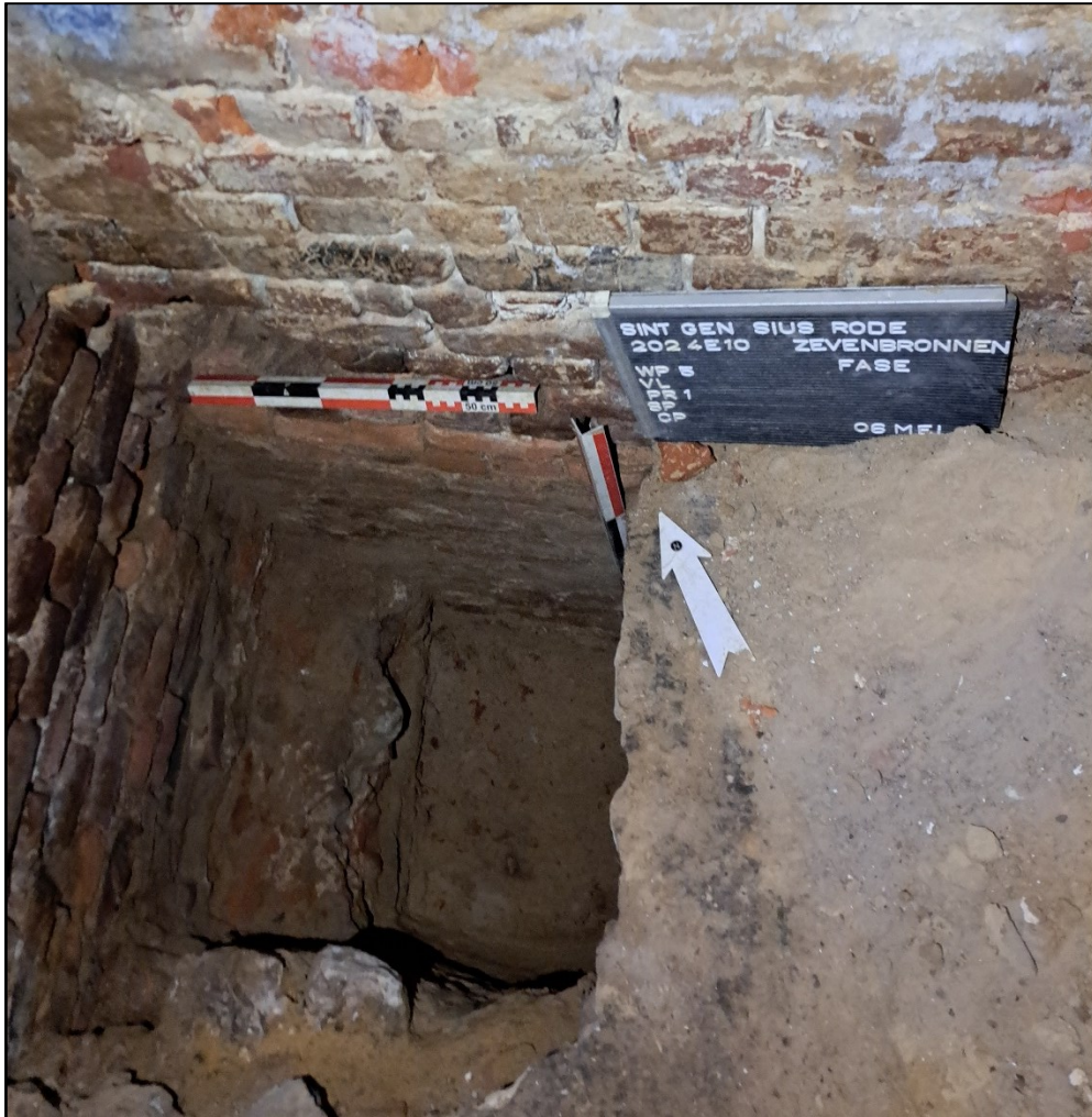
Figuur 109: Algemeen zicht op werkput 5 in de L-vormige stalvleugel (ABO nv 2024)
