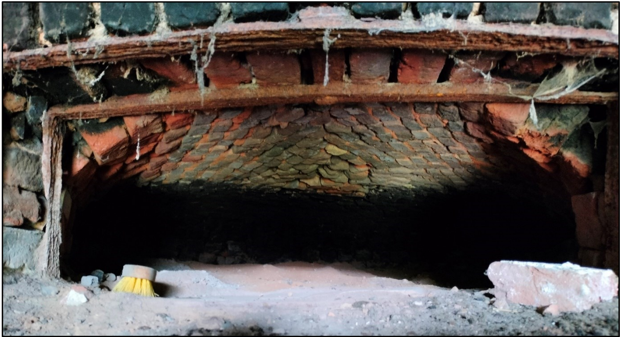
Figuur 82: Binnenzicht ovengewelf van de bakoven (ABO nv 2024)
