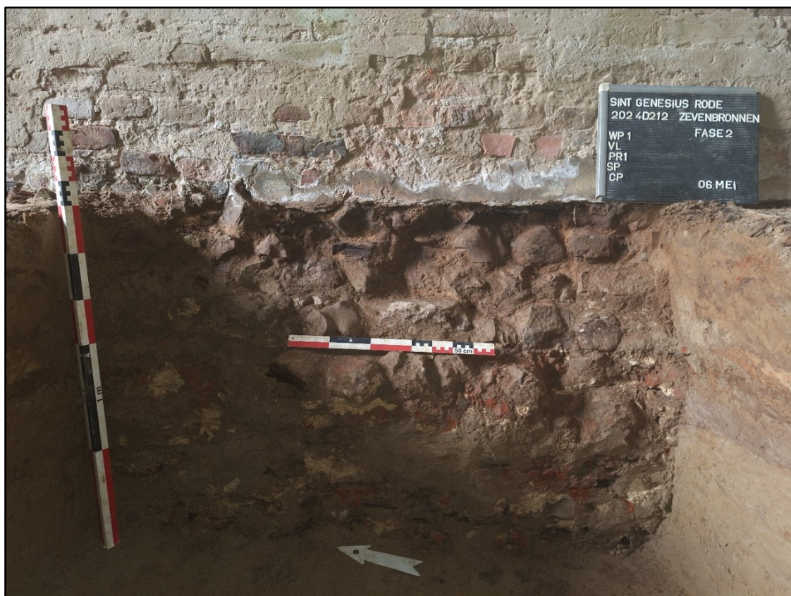
Figuur 101: Detail van de fundering (S1.1) van de oostelijke zijgevel (ABO nv 2024)
