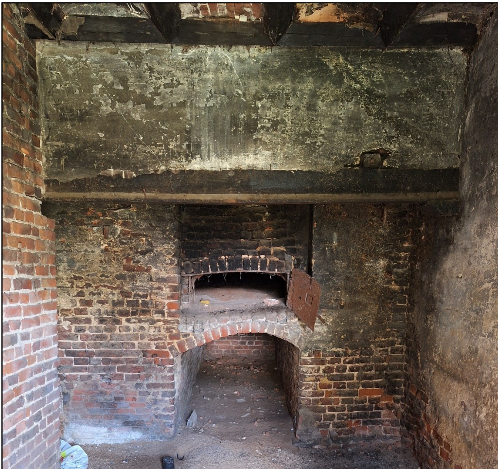
Figuur 81: Vooraanzicht bakhuis met houtgestookte bakoven in de langse stalvleugel (ABO nv 2024)
