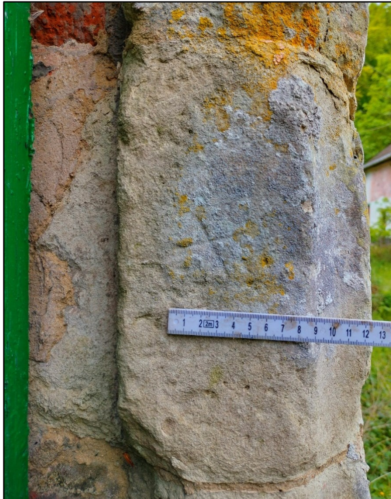
Figuur 78: Detail van een steenhouwersmerk op de negblokomlijsting van de rondboogpoort (ABO nv 2024)
