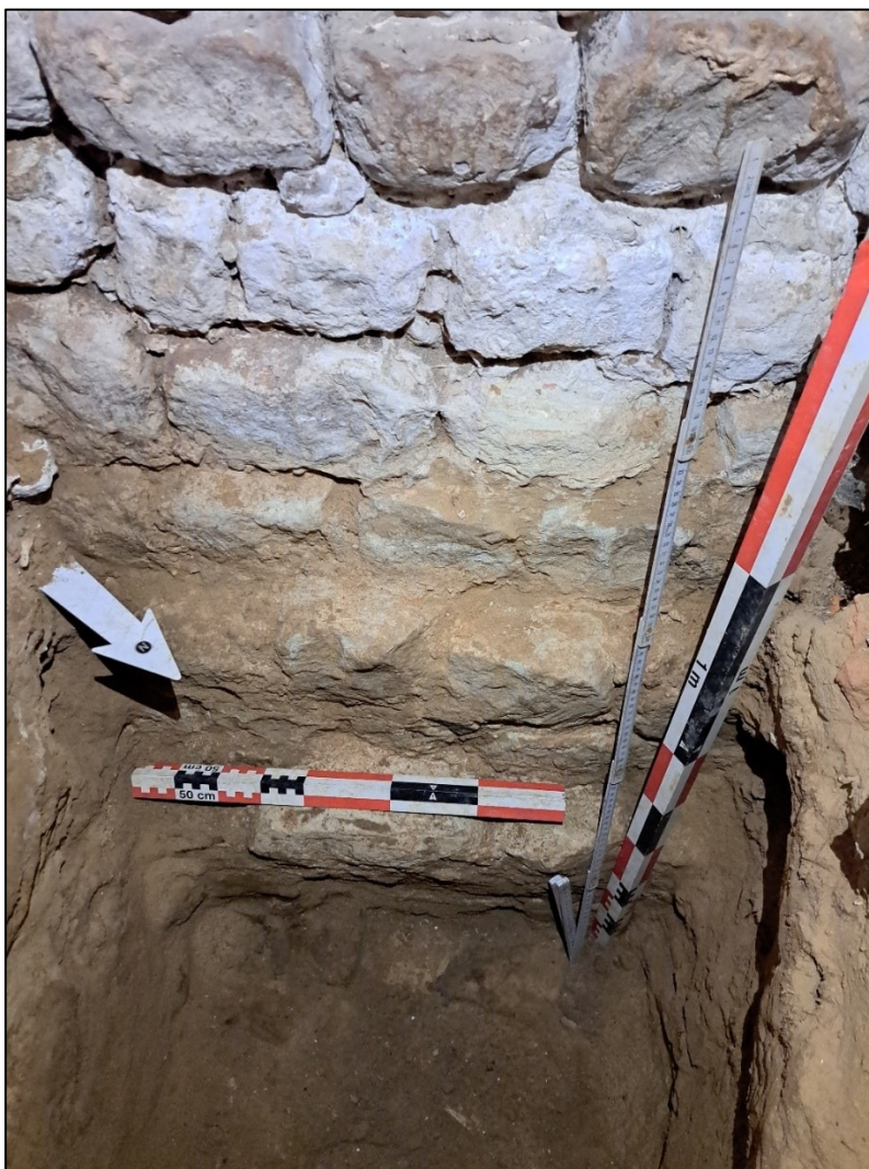
Figuur 111: Algemeen zicht op S6.1, fundering en onderfundering in regelmatige gekapte kalkzandsteenblokken (Gobertange?) in werkput 6 in de L-vormige stalvleugel (ABO nv 2024)
