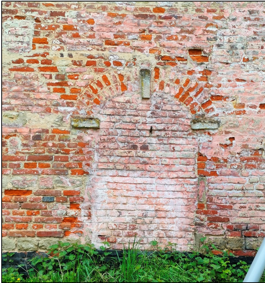
Figuur 72: Dichtgemetselde deuopening aan de rechterzijde van de voorgevel (ABO nv 2024)
