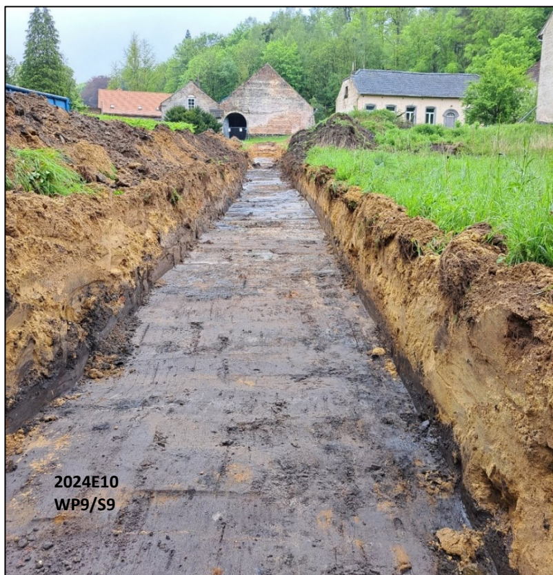
Figuur 132: S9.9 in werkput 9, bemerk de humeuze slibvulling van de vijver (ABO nv 2024)
