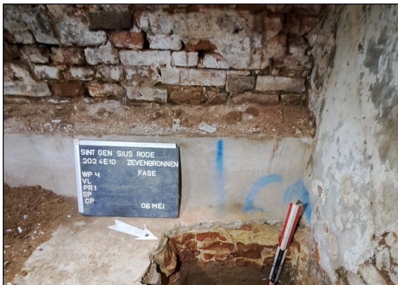
Figuur 107: Algemeen zicht op werkput 4 in de L-vormige stalvleugel (ABO nv 2024)
