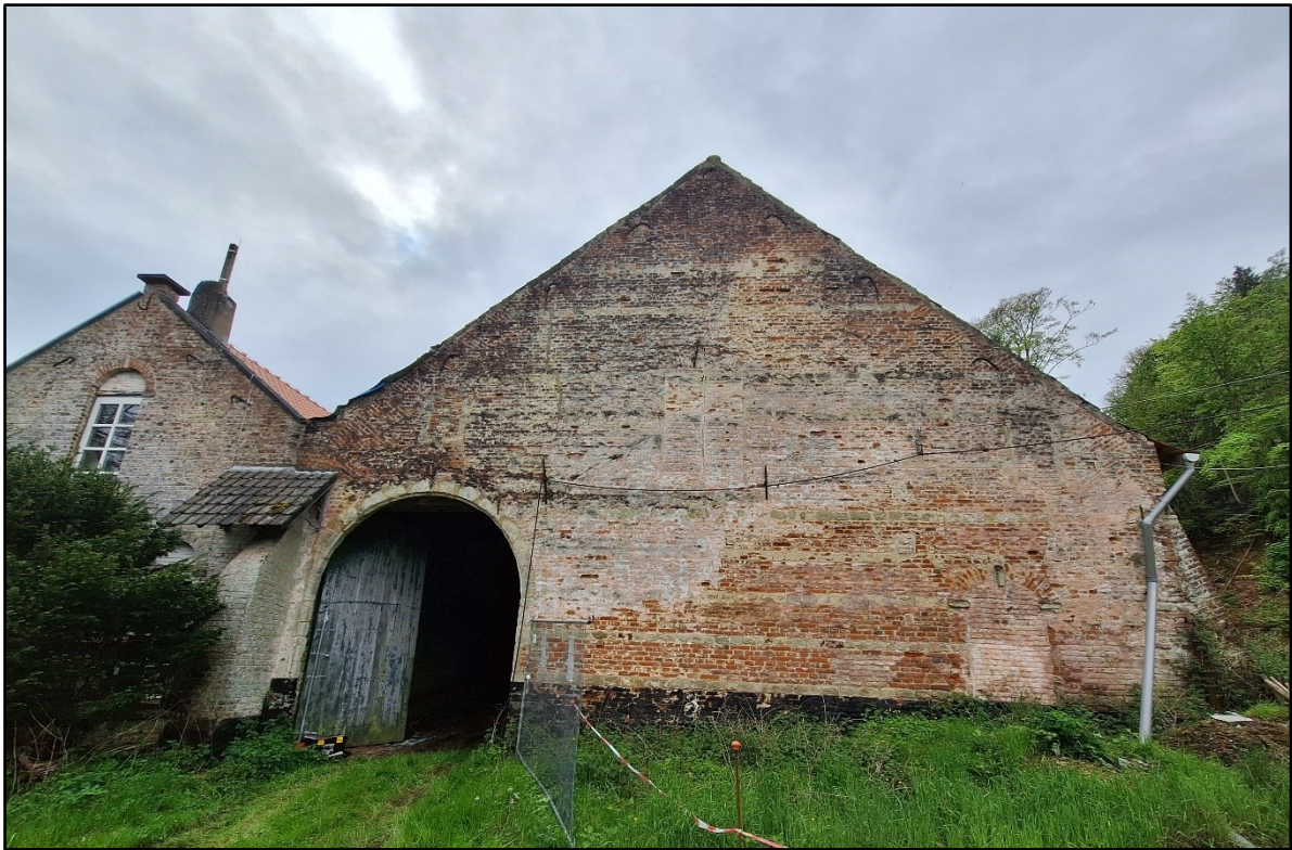
Figuur 71: Algemeen zicht op de voorgevel van de dwarsschuur (ABO nv 2024)
