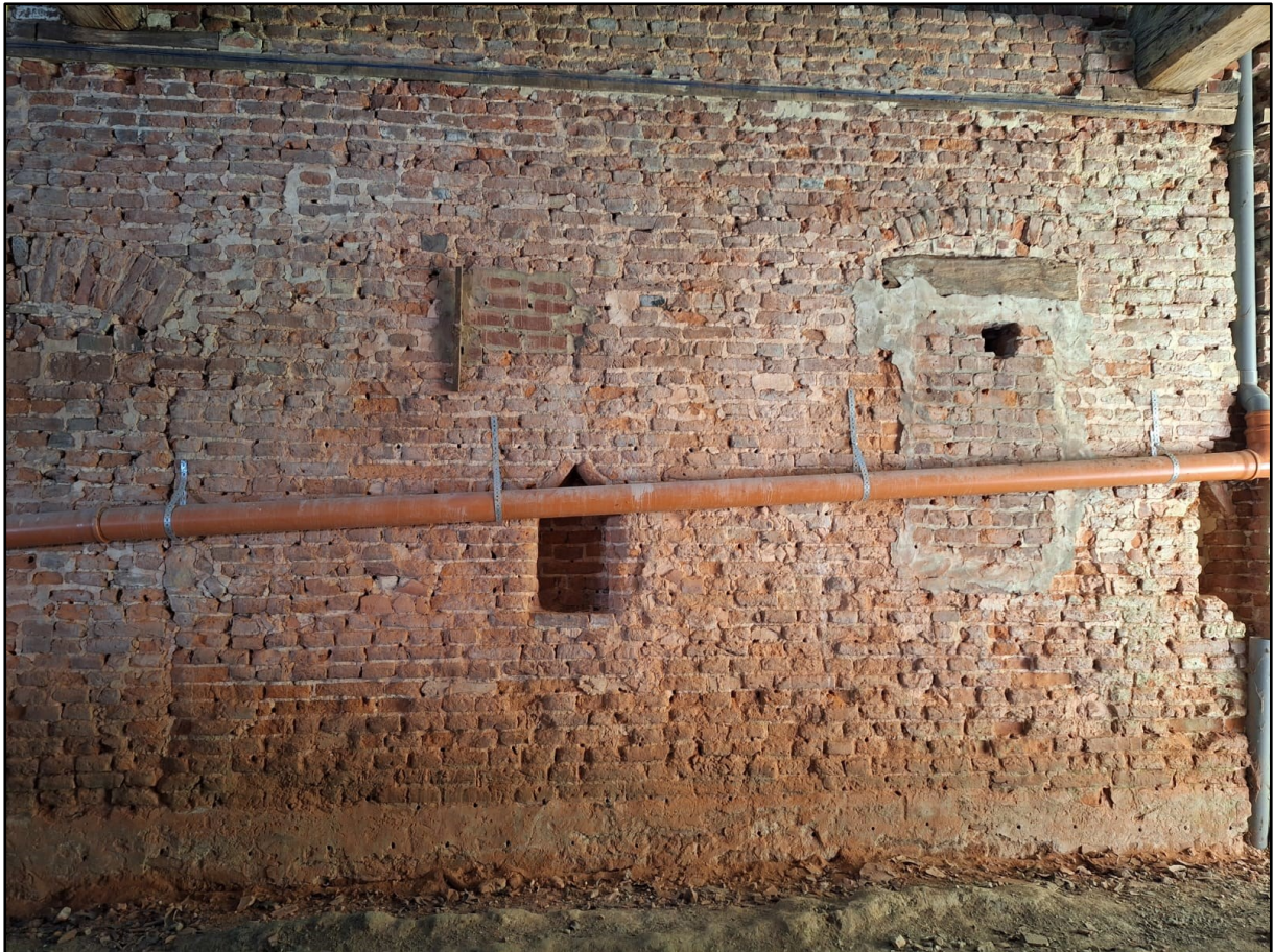
Figuur 77: Detail van de oostelijke zijgevel met kaarsnissen en dichtgemetselde deur- en raamopeningen (ABO nv 2024)
