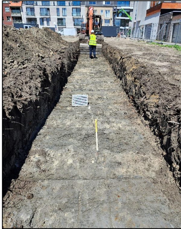
Figuur 40: Recente verstoringen (sporen van aanleg en/of sloopwerken) in werkput 3 (ABO nv 2024)
