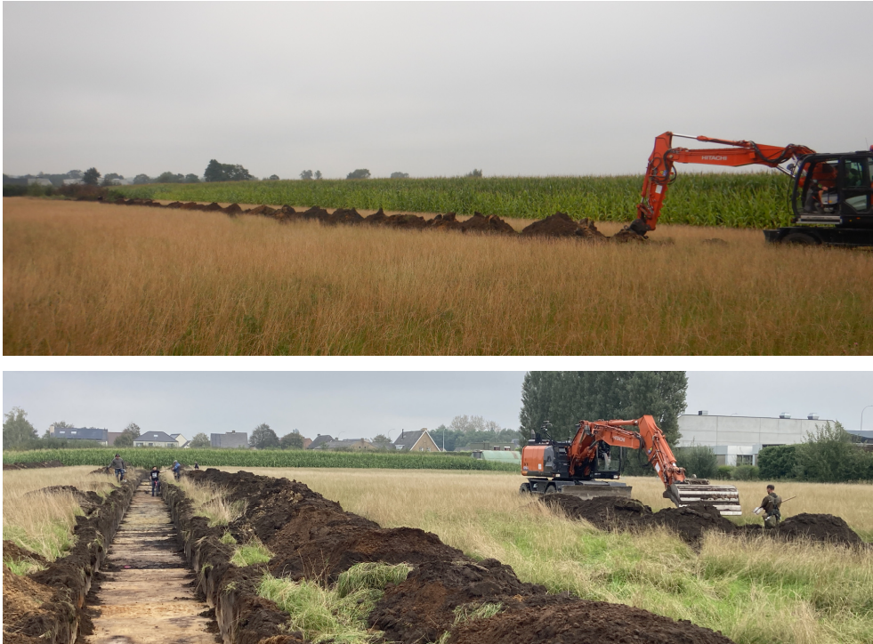
Figuur 3. Sfeerbeelden tijdens de aanleg van de proefsleuven.
