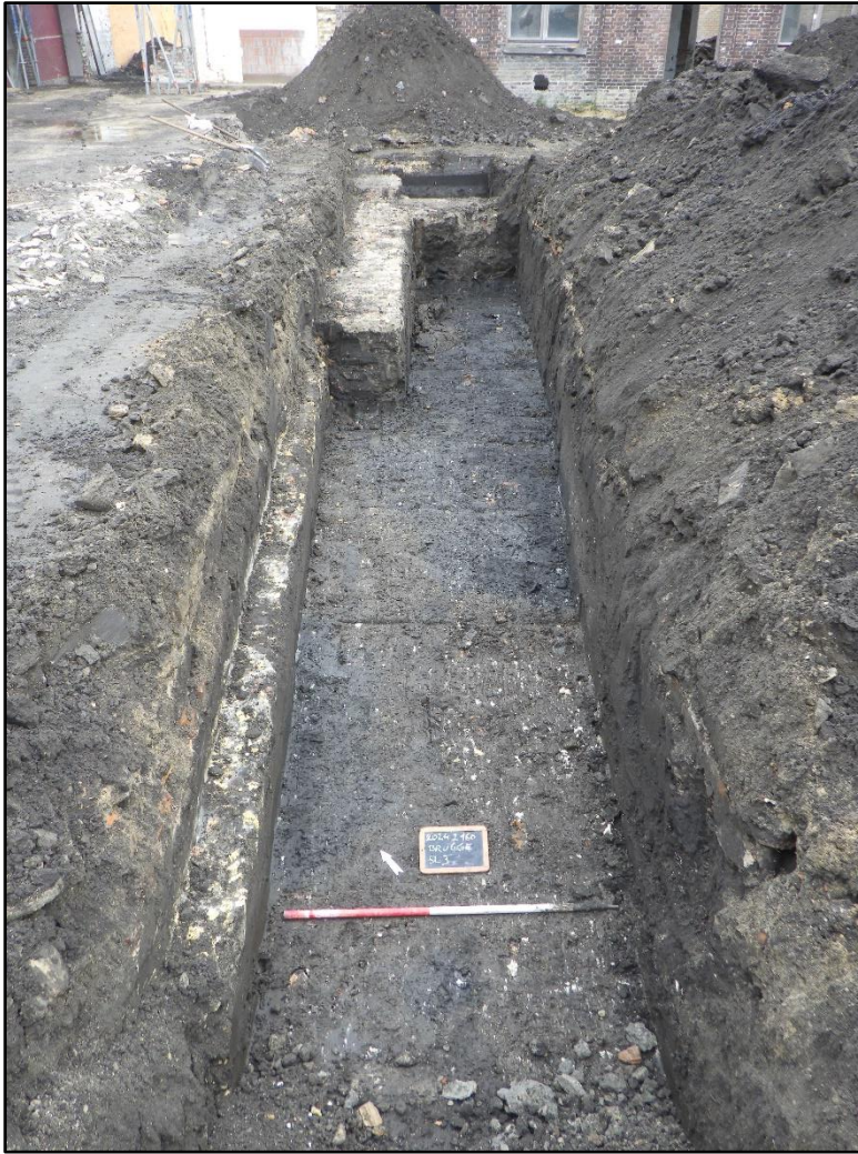
Figuur 23 Zicht op sleuf 3 met links de recentere muur S7 en achteraan de recente muurmassieven.
