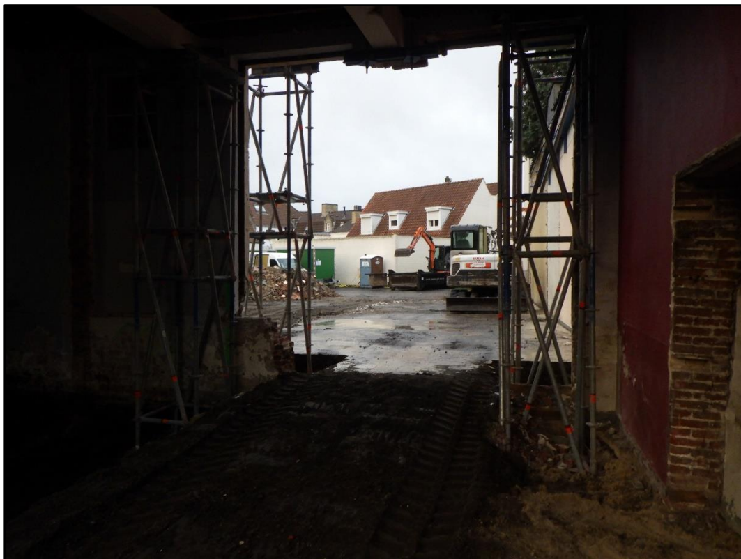
Figuur 3 Doorgang voor de kraan tussen de zuidelijke en noordelijke zone door het te behouden gebouw (foto richting het zuiden).
