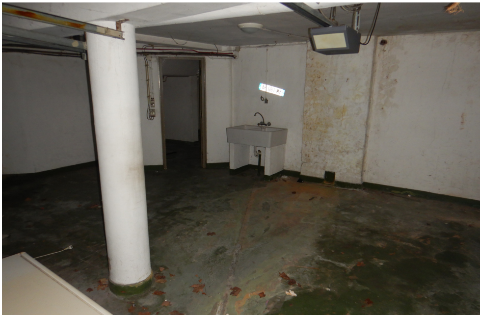
Figuur 9. Zicht op de kelder.
