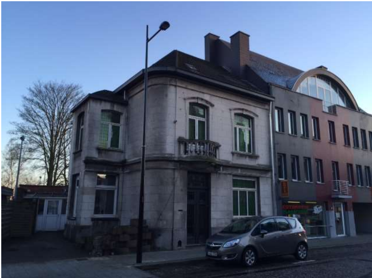
Figuur 2. Situatiefoto van het huis aan de Pas 126, dat gesloopt zal worden. ©AR'TUUR
