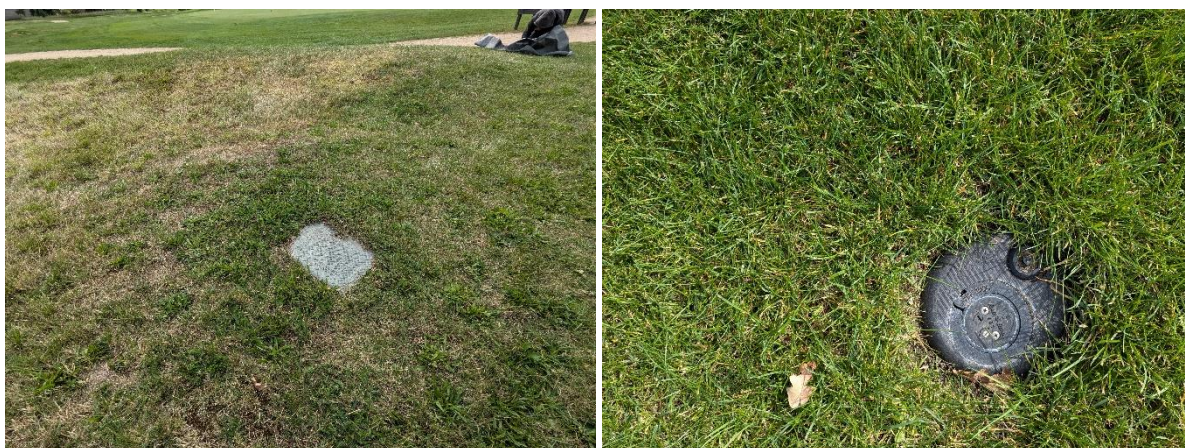
Figuur 19: Foto's van aanwezige drainage binnen het plangebied tijdens het landschappelijk bodemonderzoek (© J.Verrijckt bv)
