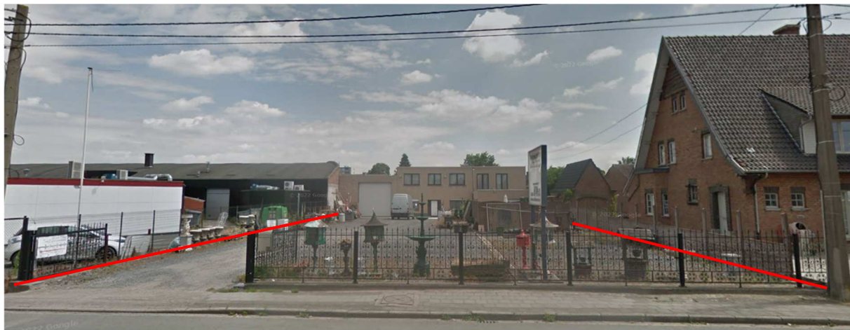
Figuur 1: Huidige situatie op het plangebied (aangeduid in rood) gezien vanop de Brugsesteenweg in oostelijke richting. 5
