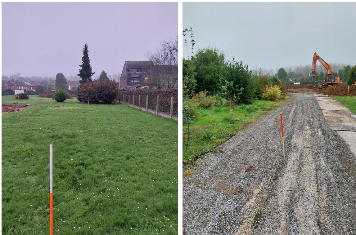
Figuur 8. Toestand terrein voor aanvang van de werken met links zicht op de te behouden bomen en beplanting in de tuinzone en rechts zicht op de te behouden werfweg alsook de groenzone in het oosten.
