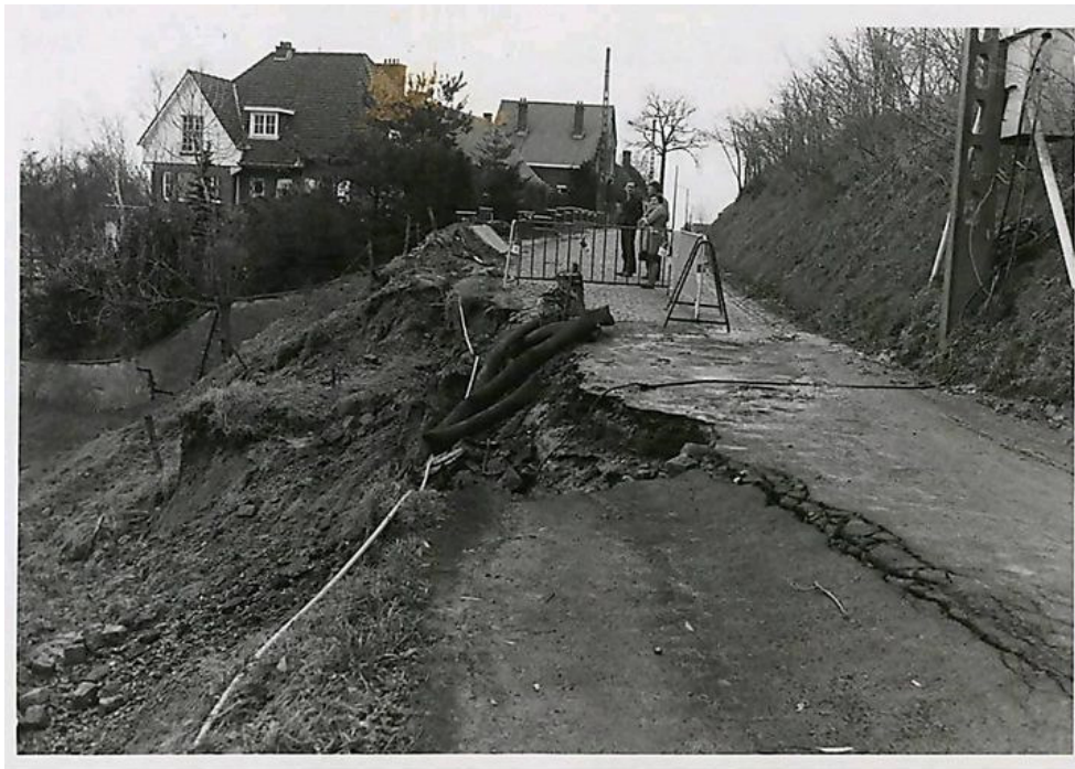
Figuur 11. Grondverzakking 4 ter hoogte van Blote 8, 100 meter ten noordoosten van het huidige onderzoeksgebied.
