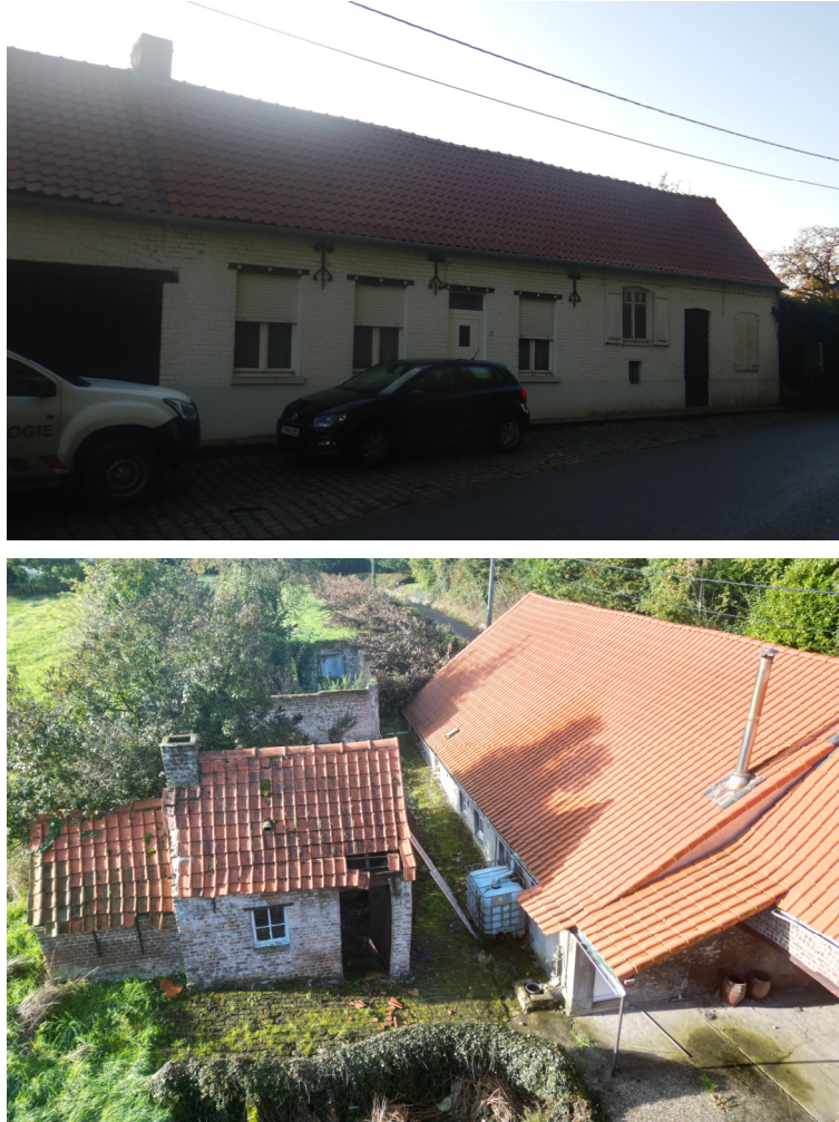
Figuur 8. Zicht op de gevel van de woning. Onder: binnenkoer met bakhuisje en vervallen bijgebouw.
