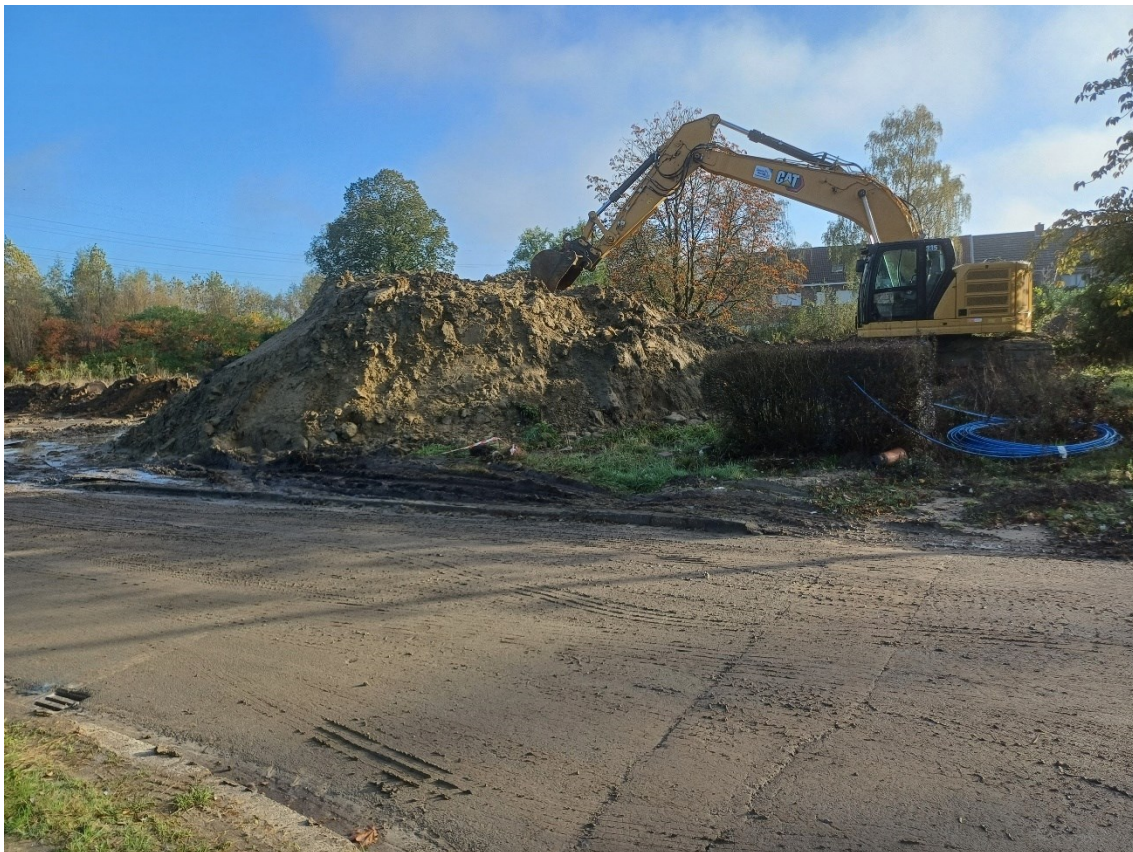
Figuur 36: Werkfoto grondhoop en kraan waardoor werkputten ingekort moesten worden
