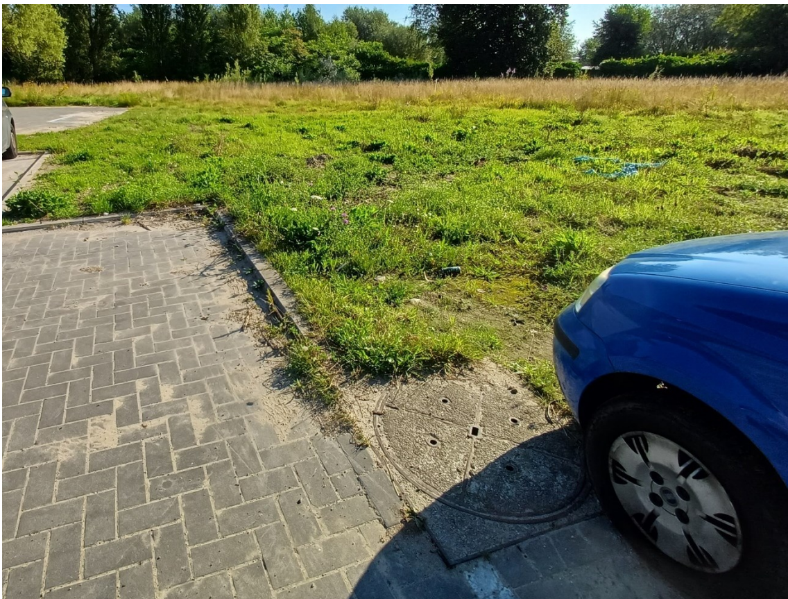
Figuur 11: Riooldeksel van de ingebuisde gracht
