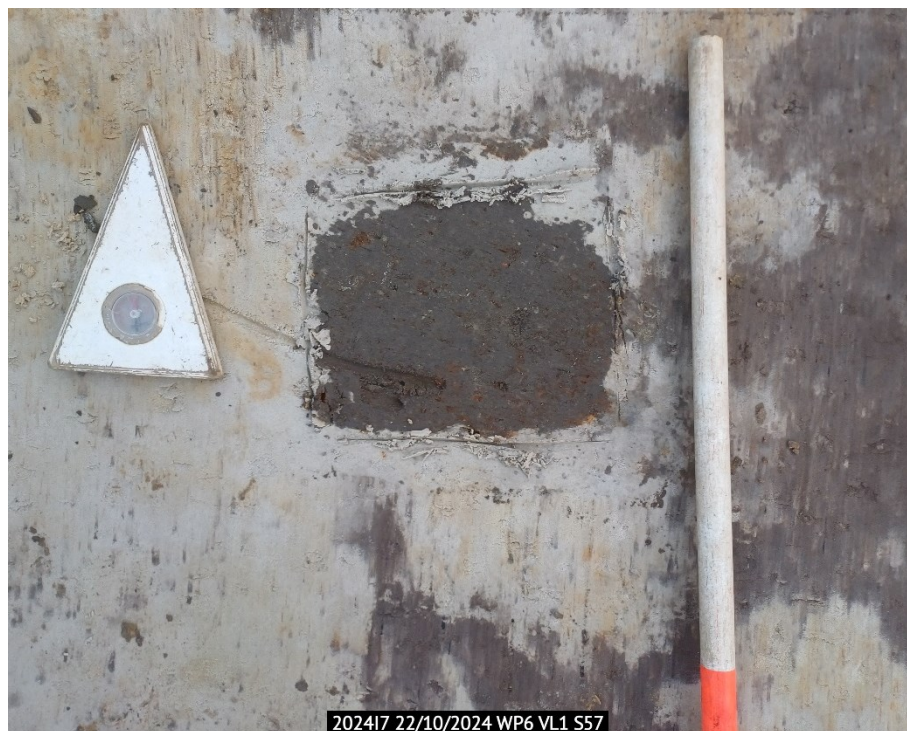
Figuur 44: Paalspoor S57
