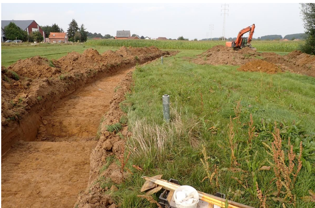
Afb. 13. Aanleggen van werkput 6 met behoud van de aanwezige pijlbuizen.
