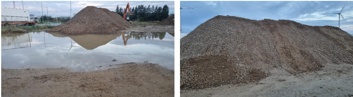
Figuur 19. Zicht op wateroverlast en zandberg die obstakel vormden om werkput 5 aan te leggen.
