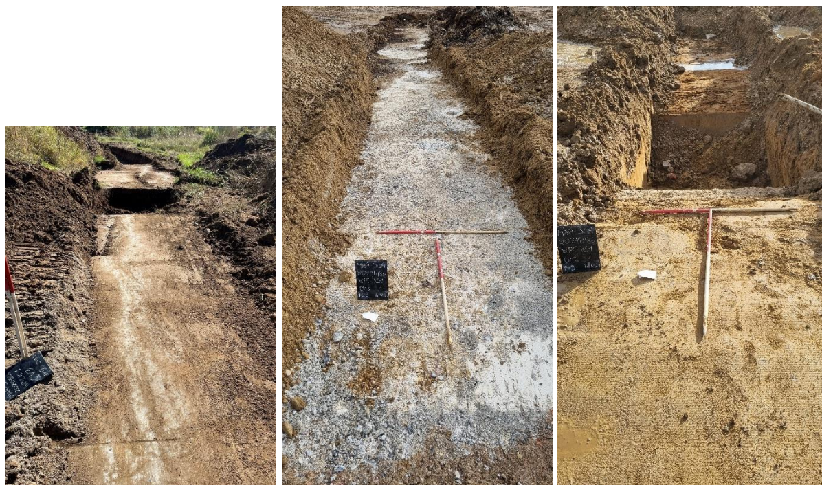
Figuur 30. Zicht op versterking in werkput 2 (links) en in werkput 5 (centraal en rechts).
