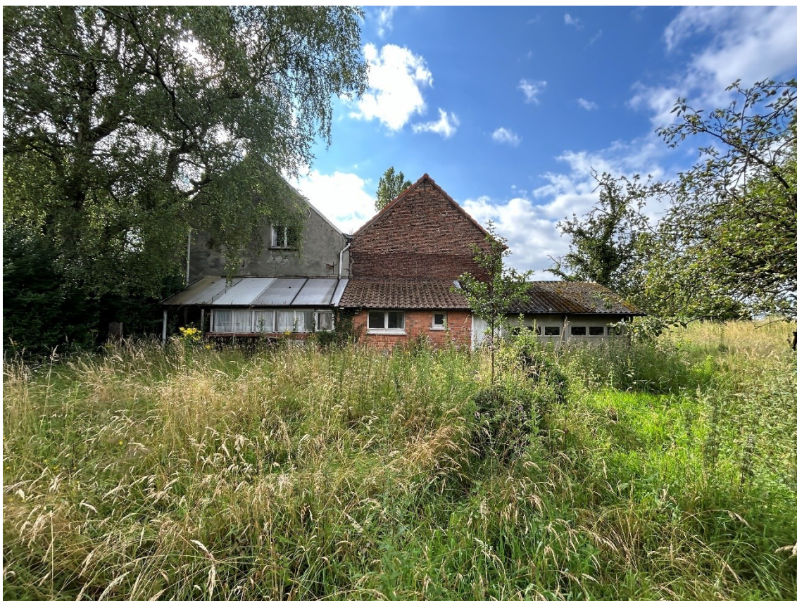
Figuur 6: Te slopen bebouwing
