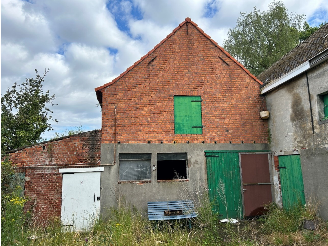
Figuur 4: Te slopen bebouwing
