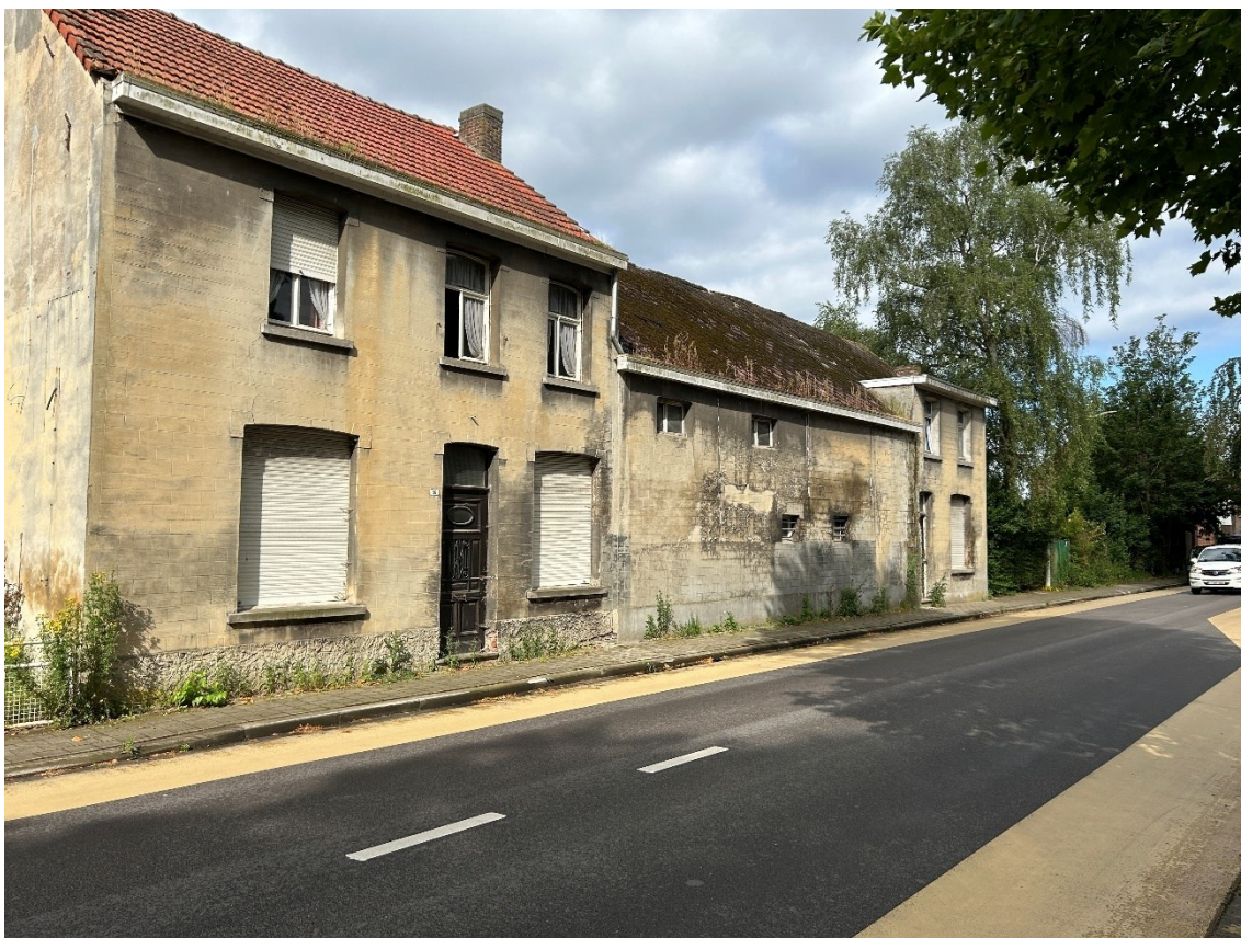
Figuur 8: Te slopen bebouwing
