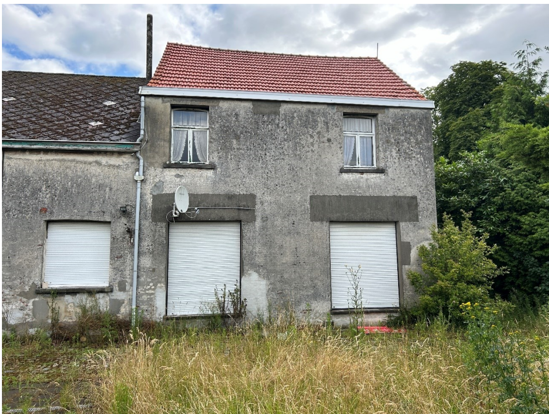
Figuur 5: Te slopen bebouwing
