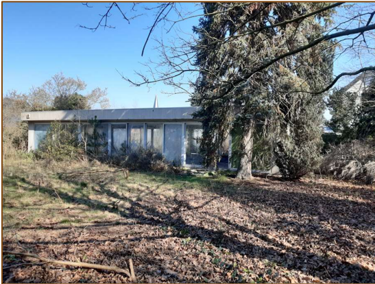
Foto 16: Bijgebouw buitenkant in het tweede tuinvlak (W naar O)
