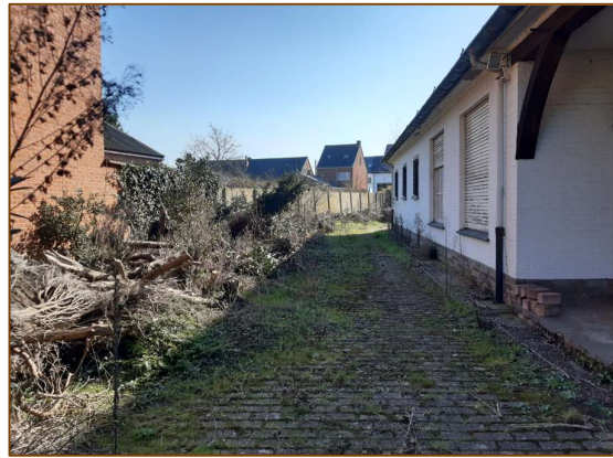
Foto 2: NO zijgevel van de villa (N naar Z)
