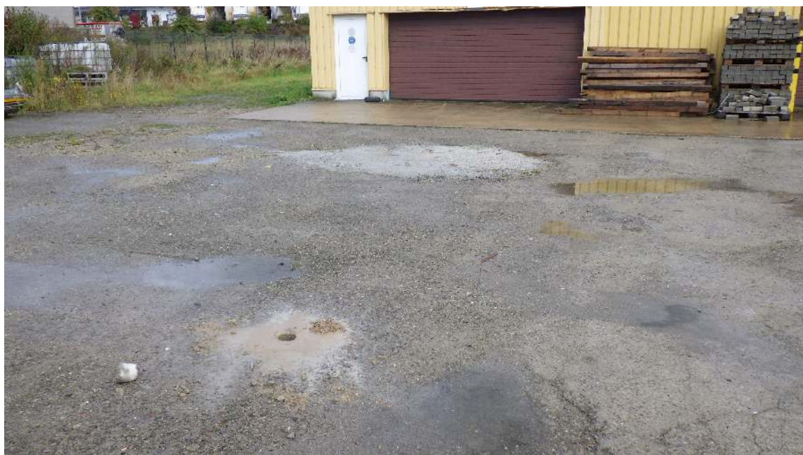
Afbeelding 3.6.2: De verharde zone waar begonnen werd met de uitvoering van een kernboring.
