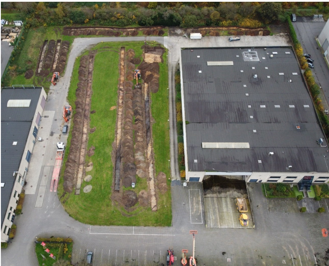
Figuur 16: Dronebeeld van de aangelegde proefsleuven
