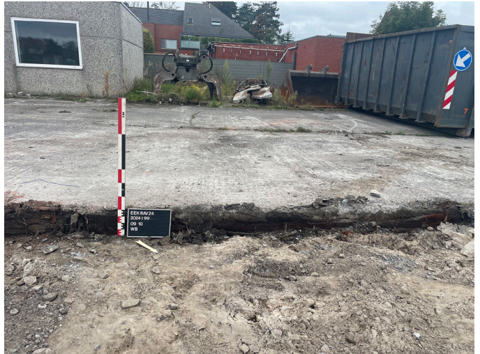
Figuur 16: Zicht op de opbouw van de betonplaat in zuiden
