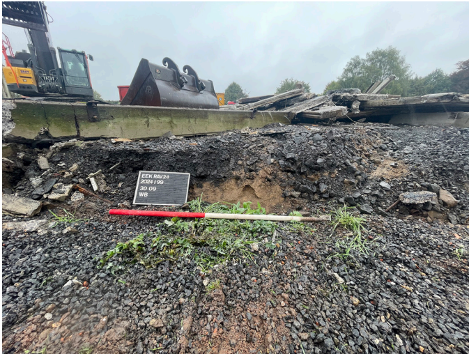
Figuur 15: Zicht op de verharding grenzend aan de loods centraal
