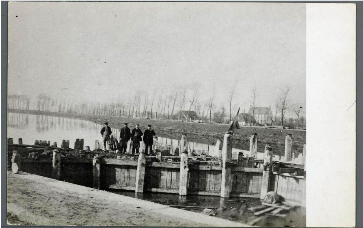
Figuur 13: Uitgraven van een afleidingskanaal aan de Houtkaai te Sint-Pieters-op-den-Dijk, Kasteel Ruddershove op de achtergrond (erfgoedbrugge.be)
