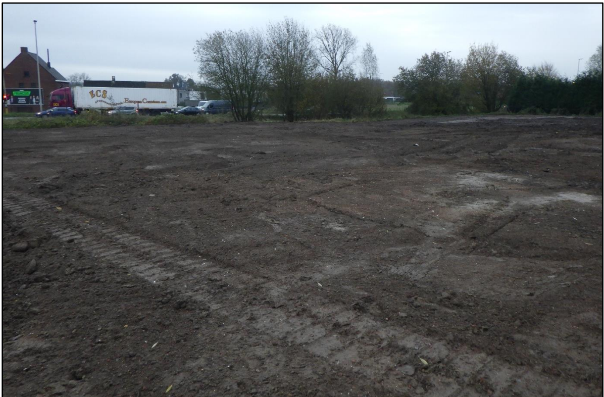
Figuur 5 Zicht op het plangebied na de bovengrondse sloop en rooi (foto genomen naar het zuiden).
