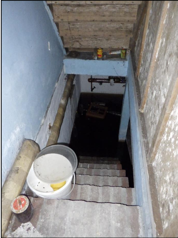
Figuur 1 Zicht op de grote kelder in huisnummer 2 voorafgaand de sloopwerken.
