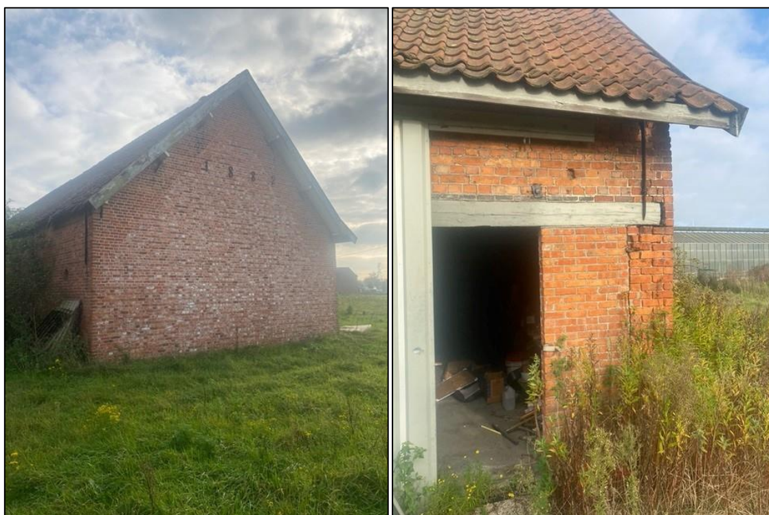
Figuur 34: De zijkant van de loods met jaartal erop (links) en de ingang van de loods, waarbij een deel is verdicht (rechts) 14
