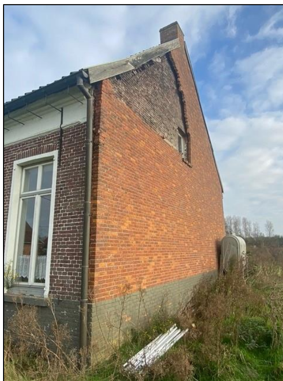
Figuur 33: De aangebouwde spouwmuur bij het woonhuis 13
