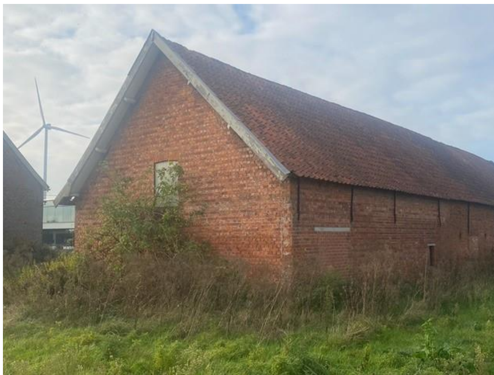
Figuur 35: Aan de lange zijde van de loods is de balk waar de vroegere deur heeft gezeten nog zichtbaar en het gat van de deur is opgevuld met andere bakstenen. 15
