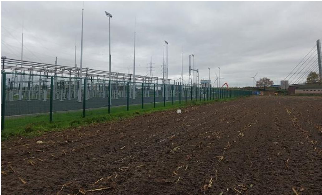
Figuur 5: Foto van het terrein tijdens het onderzoek. Links het station, rechts de akker in het noorden. Op de achtergrond de brug over het kanaal.
