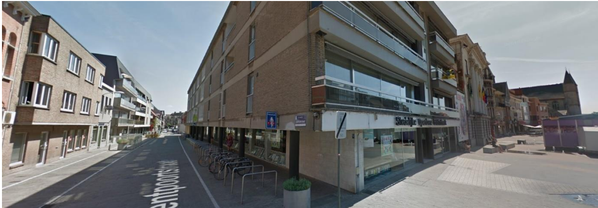
Figuur 3. Zicht op de huidige bibliotheek, ter hoogte van het kruispunt van de Markt met de Gentpoortstraat (bron: Google Maps, 2018).
