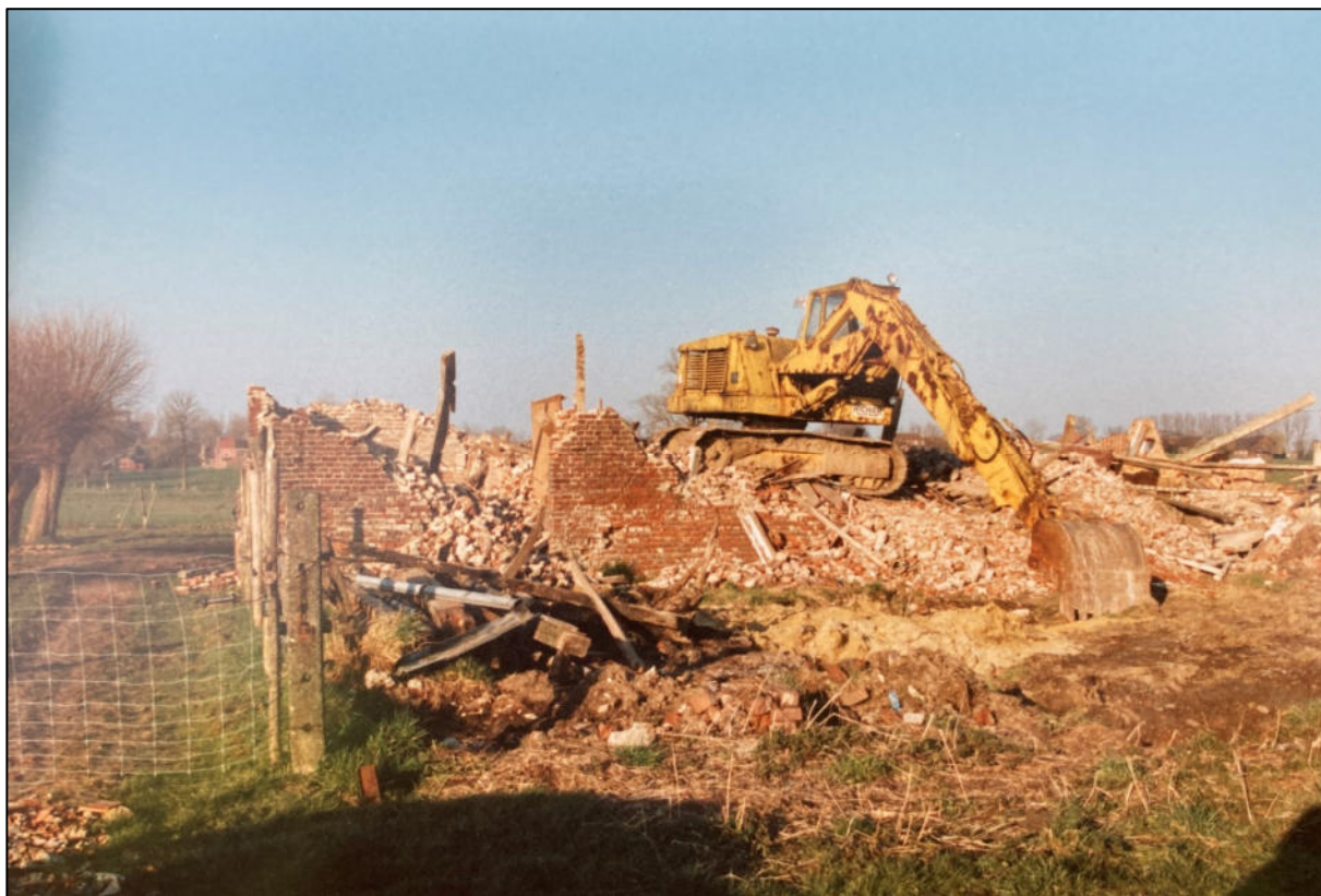
Figuur 64: Foto's van de graafwerken ter hoogte van het huis ten oosten van de winterbedding.
