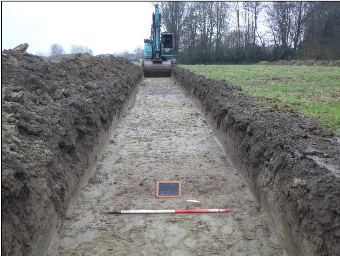
Figuur 17 Zicht op sleuf 3.
