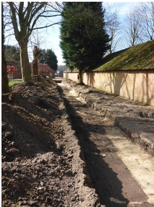
Figuur 7: Overzicht van het aanleggen van de sleuf ter hoogte van de noordwestelijke stal.
