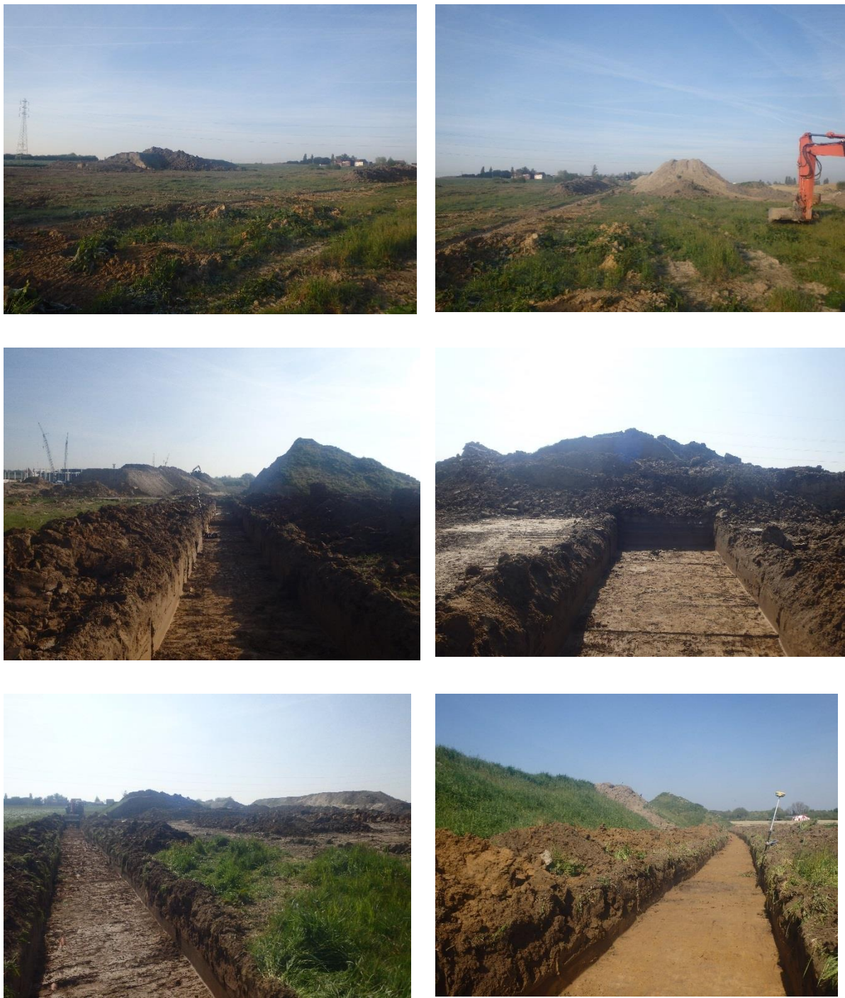
Figuur 3: Aanwezigheid van grote hopen aarde waardoor het sleuvenplan ter plaatse aangepast moest worden.
