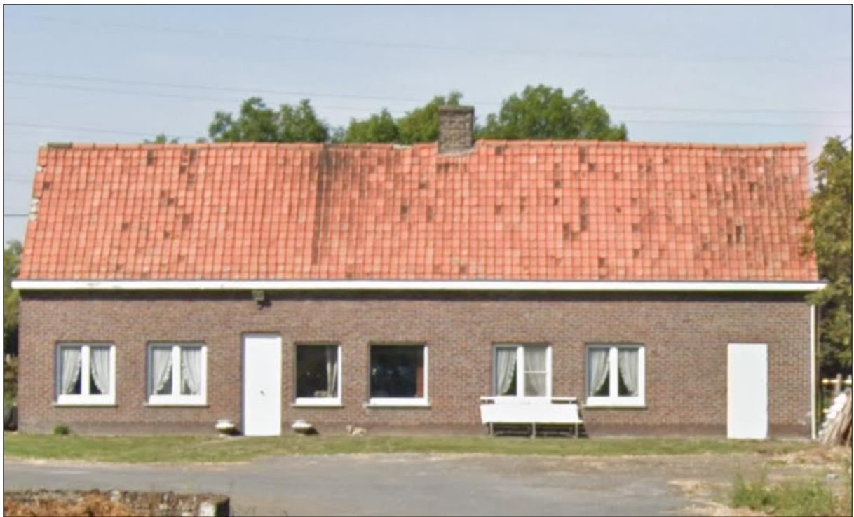
Figuur 20: Westelijk gebouw van de hoeve (Bron: Google Streetview).
