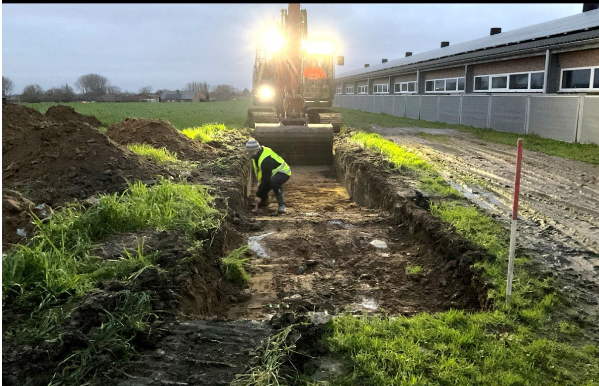
Figuur 10: Aanleg van de proefsleuven
