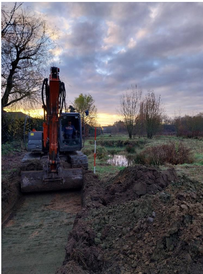
Figuur 14. Aanleg van proefsleuf met een rupskraan met gladde graafbak.
