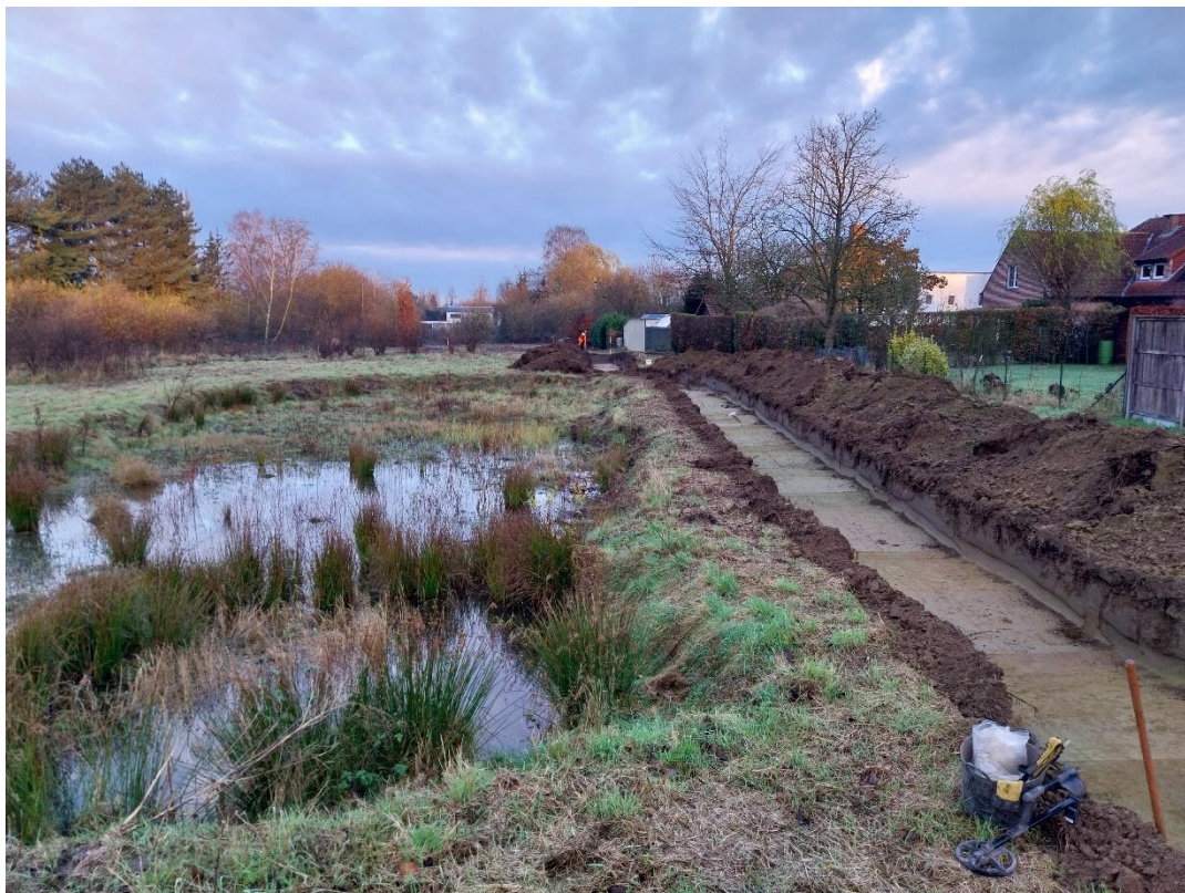
Figuur 10. Zicht op het aanleggen van werkput 1 net naast een waterverzadigde depressie.
