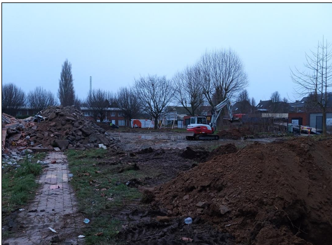
Figuur 22: Stortberg ten gevolge van de sloopwerken in het noordelijke deel van het projectgebied, licht overlappend met het onderzoeksgebied t.h.v. het uitgebroken verharde speelterrein (ABO nv 2024).
