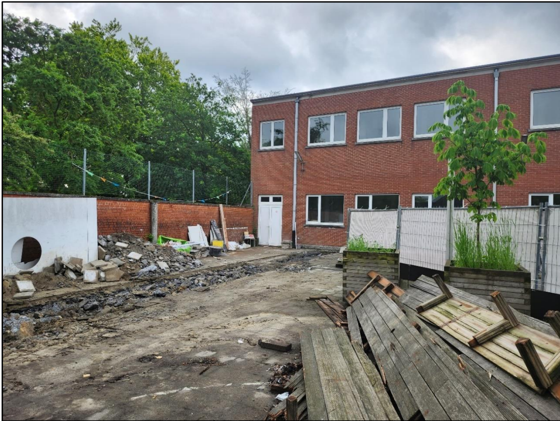
Figuur 23: Illustratie van de terreinomstandigheden op het moment voor het aanleggen van de proefsleuf in onderzoekzone 3 (ABO nv 2024)
