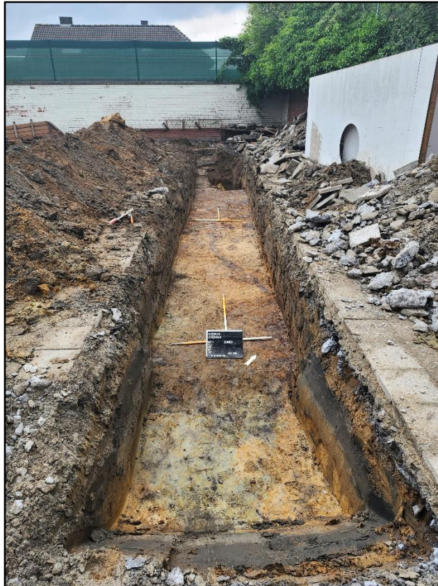
Figuur 27: Overzichtsfoto van WP 1 in de deelgebied 3, vanuit het zuiden – zuidoosten (ABO nv 2024)
