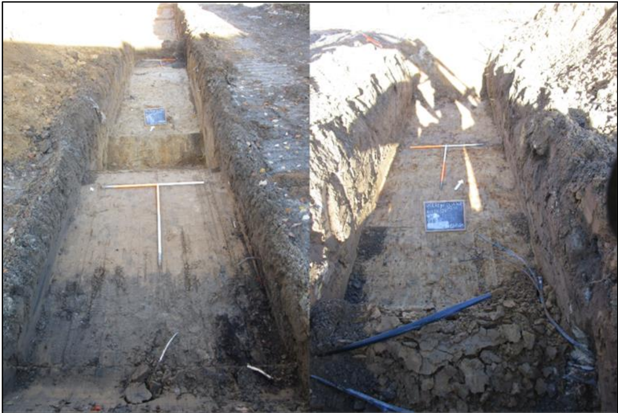
Figuur 35: Recente verstoringen in het onderzoekzone 1. Links: uitbraakspoor in WP 1. Rechts: kabels en geroerde grond in WP 2 (ABO nv 2020)
