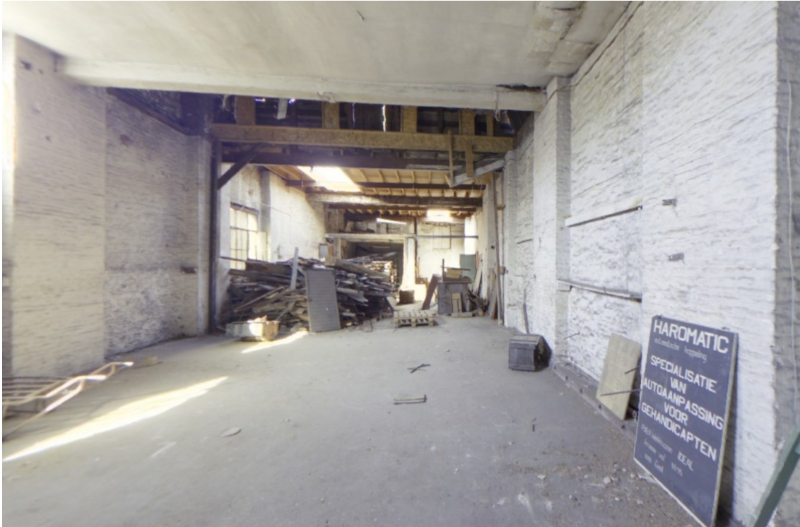
Figuur 7: Zicht binnen één van de loodsen op het terrein
