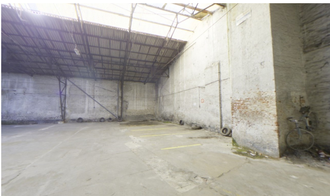
Figuur 6: Zicht binnen één van de loodsen op het terrein
