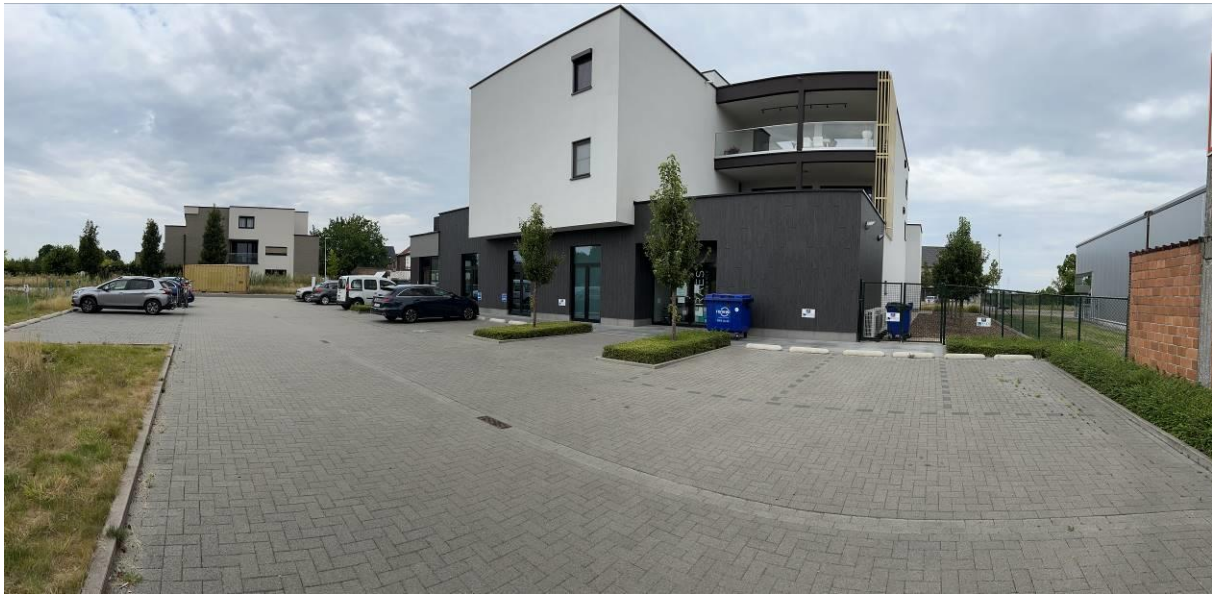
Figuur 7. Het noordelijk, bebouwd deel van het projectgebied-fase-2. (Foto: Triharch 16/08/2022)
