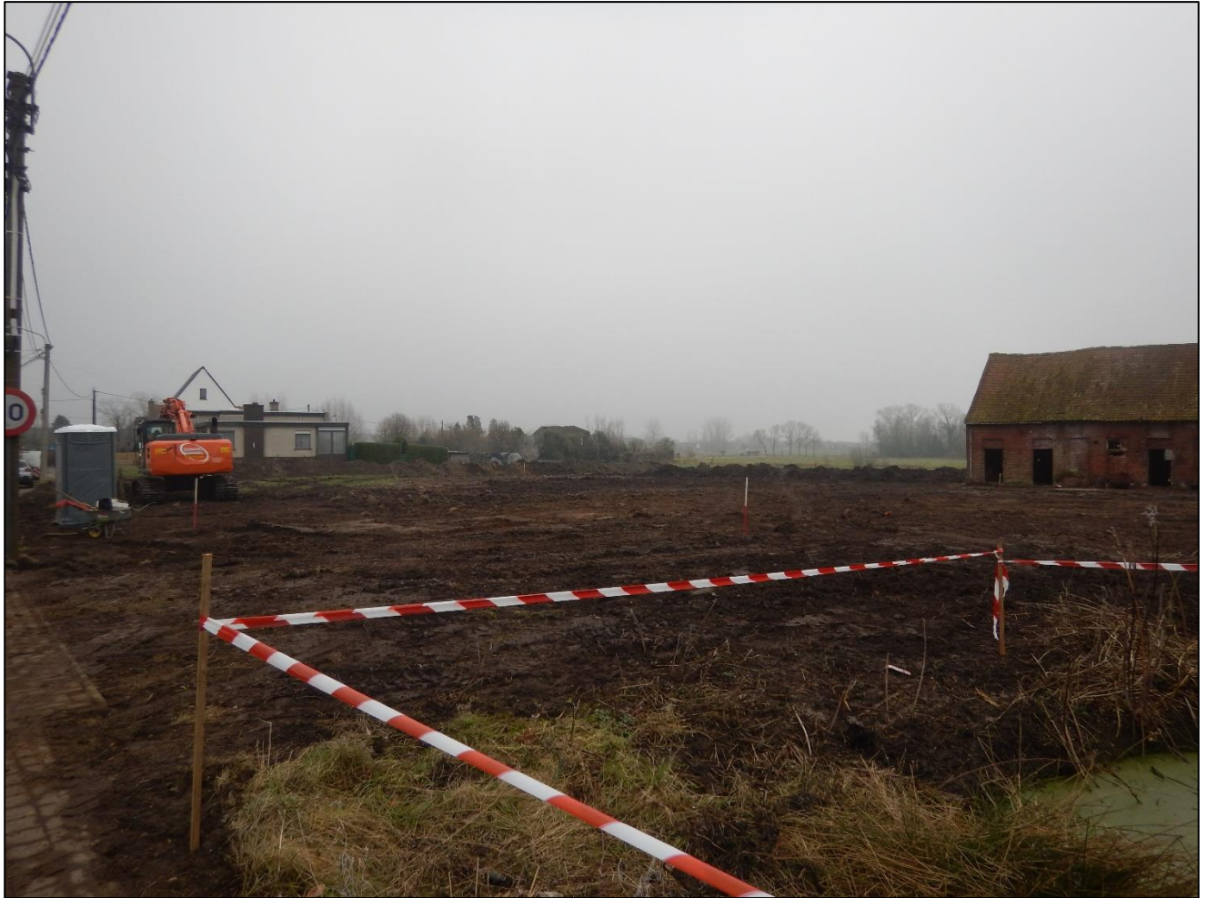
Figuur 6: Terreinomstandigheden, zicht vanuit de noordwestelijke hoek, kijkend naar het zuidwesten. Op de voorgrond is de poel te zien.
