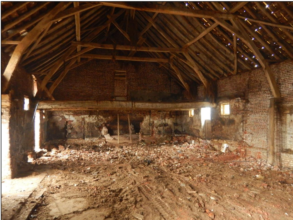
Figuur 9: Binnenzicht op de te herbestemmen schuur.
