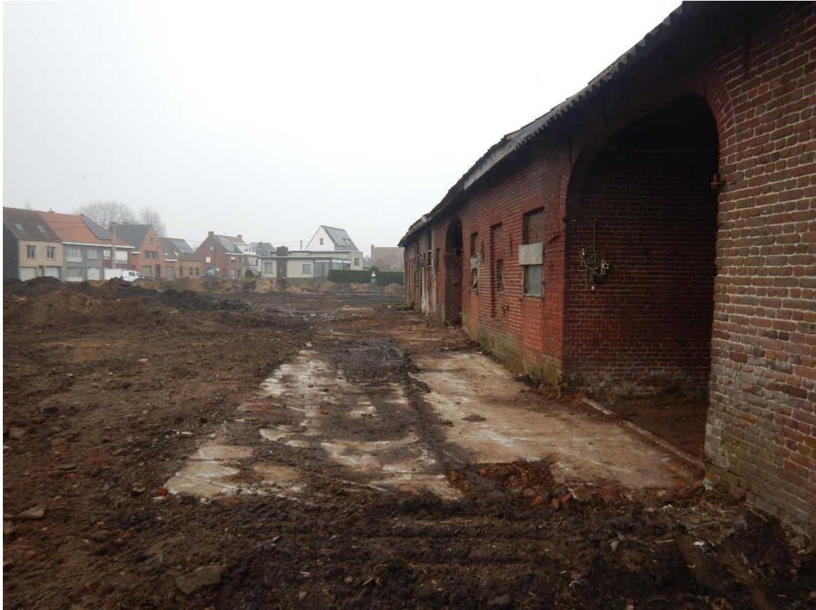
Figuur 14: Betonnen verharding tot tegen de te herbestemmen schuur (noordzijde).
