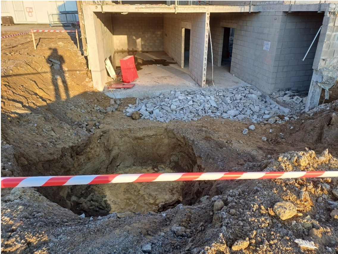
Figuur 9: Foto van het gat langs het bestaande, te behouden gebouw
