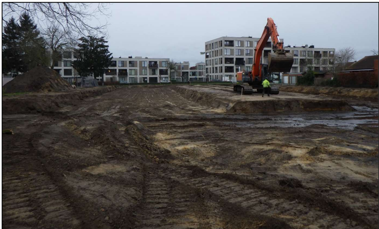
Figuur 2 Beeld vanuit het oosten op het plangebied van fase 2, met op de voorgrond, centraal en uiterst rechts de verlaagde zone waar de kelders zijn uitgegraven, en daartussen en links de hogere zones waar geen gebouwen stonden. Bemerkt de grondhoop links.
