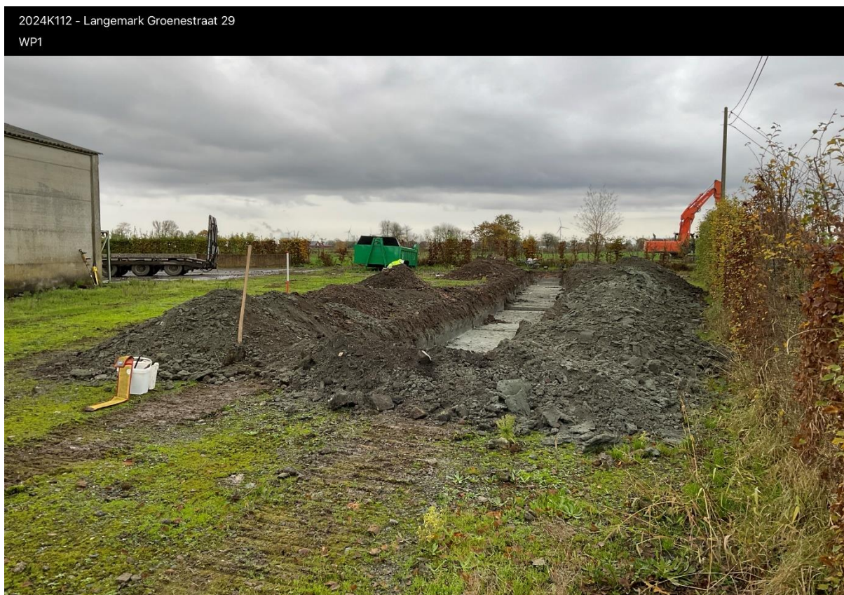
Figuur 35: fotografische opname van het zuidelijk deel van sleuf 1 met zicht op de afbuiging en haag. In de hoek bevindt zich nog verspreid een aantal grote betonplaten, oorzaak voor de afbuiging.
