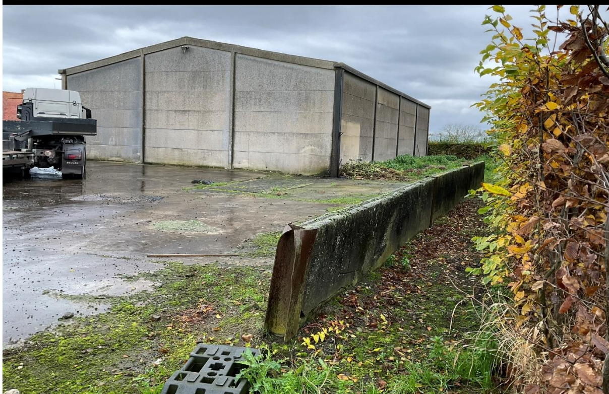
Figuur 37: fotografische opname van de noordzijde van sleuven 2 tem 6 met zichtbare haag en bestaande ingeheide bouwplaten.
