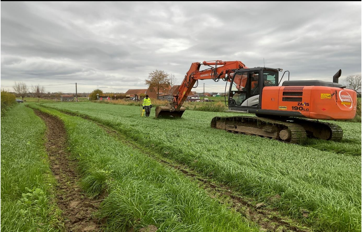
Figuur 32: fotografische opname van het zuidelijk deel van het projectgebied tegen het Ledwidgepad.
