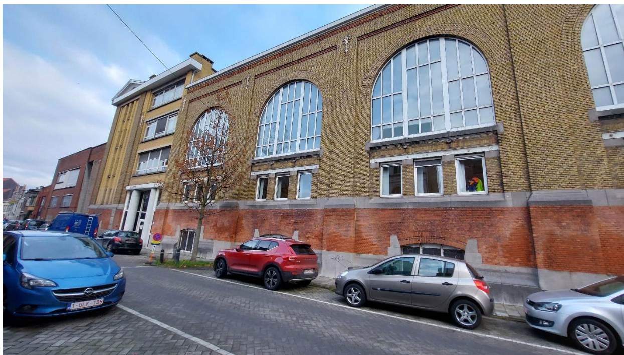
Figuur 7: Gebouw A
