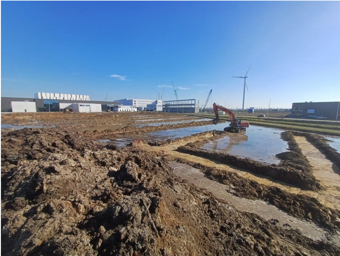
Figuur 6: Werkfoto graven van proefsleuven door onderstaand terrein
