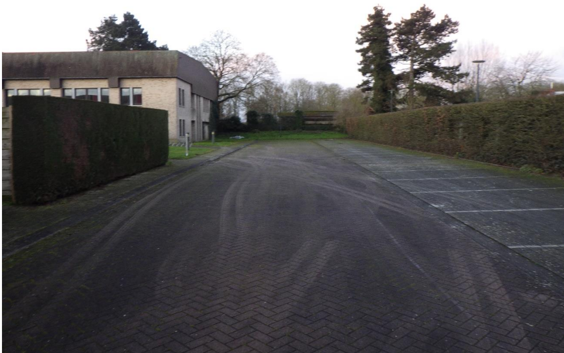
Figuur 11: Terreinsituatie voor aanleg van de proefputten ter hoogte van WP4-6
