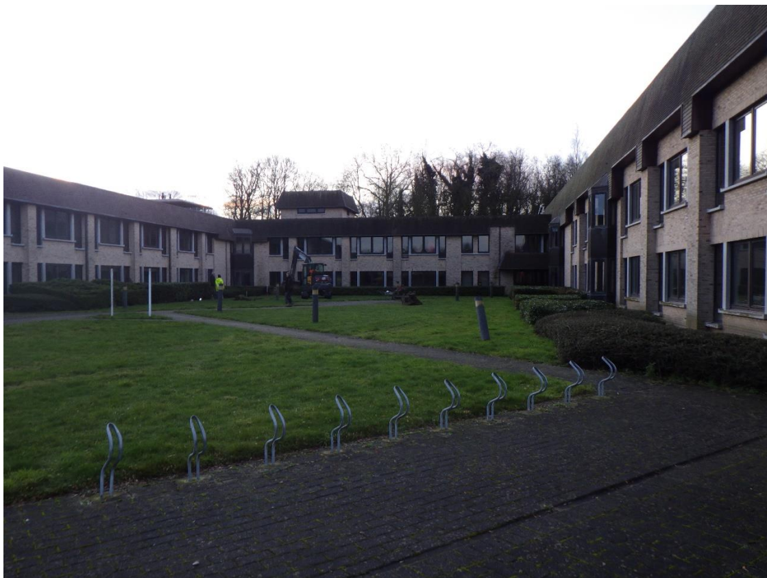
Figuur 9: Terreinsituatie voor aanleg van de proefputten ter hoogte van WP1 en WP2
