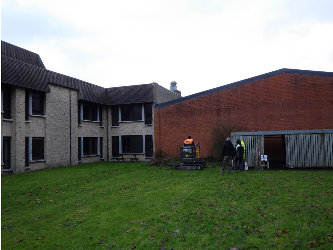
Figuur 10: Terreinsituatie voor aanleg van WP3
