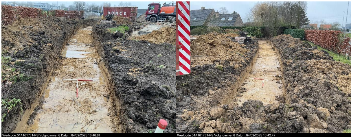
Figuur 32: Overzichtsfoto's sleuf 4 vanuit het zuidoosten (links) en noordwesten (rechts)
