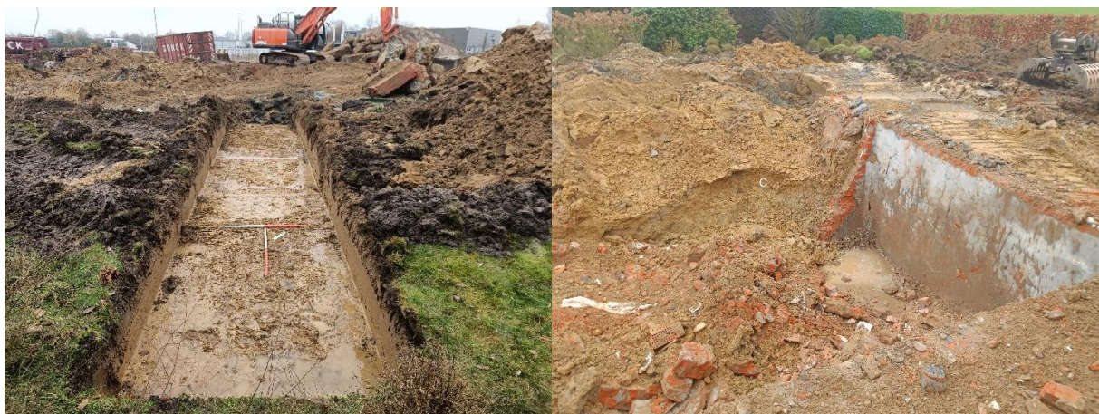
Figuur 31: Ingekorte sleuf 3 (links) en uitbraak kelder tijdens werfbegeleiding (rechts) De kelder en funderingen situeerden zich duidelijk tot diep in de moederbodem.
