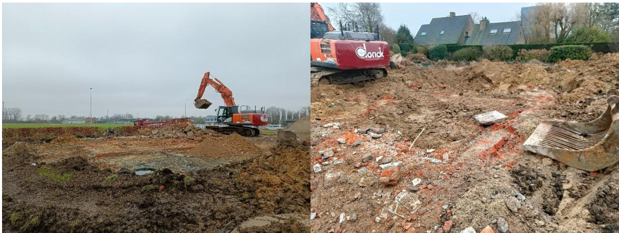
Figuur 19: Terrein voor de uitbraak van de centrale fundering en kelder
