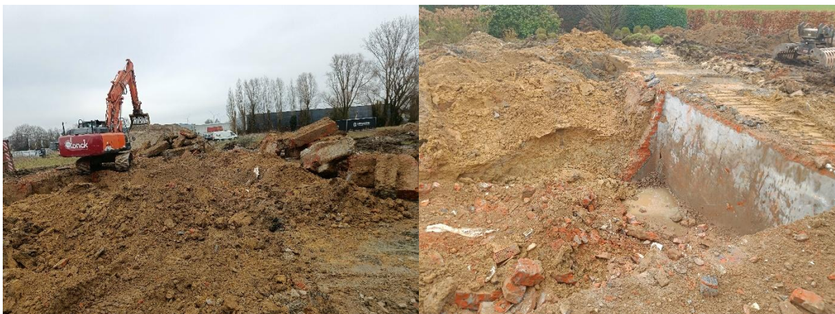
Figuur 20: Uitbraak van de funderingen (links) en kelder (rechts). De recente infrastructuur snijdt duidelijk tot in de moederbodem waardoor het bodemarchief hier volledig verstoord is.
