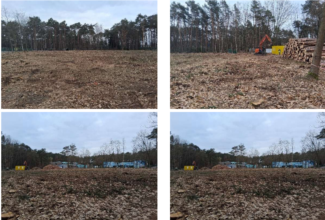
Figuur 16. Selectie van de terreinfo's genomen tijdens het proefsleuvenonderzoek. ©LARES
