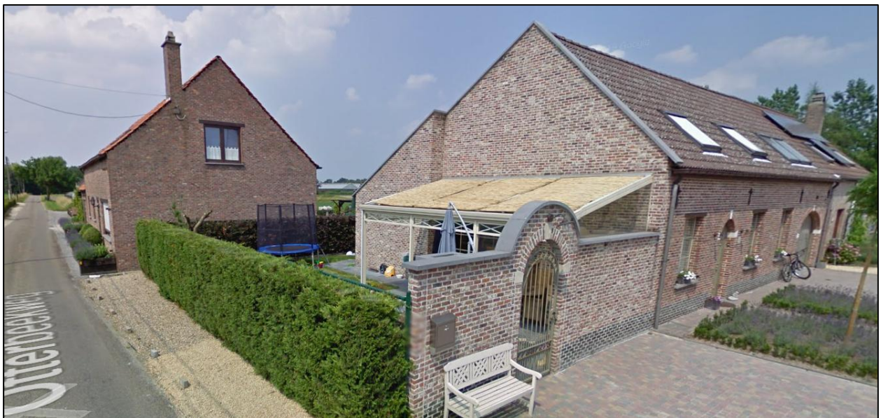
Figuur 4: Google Streetview beeld van de in 2016 gesloopte woningen.
