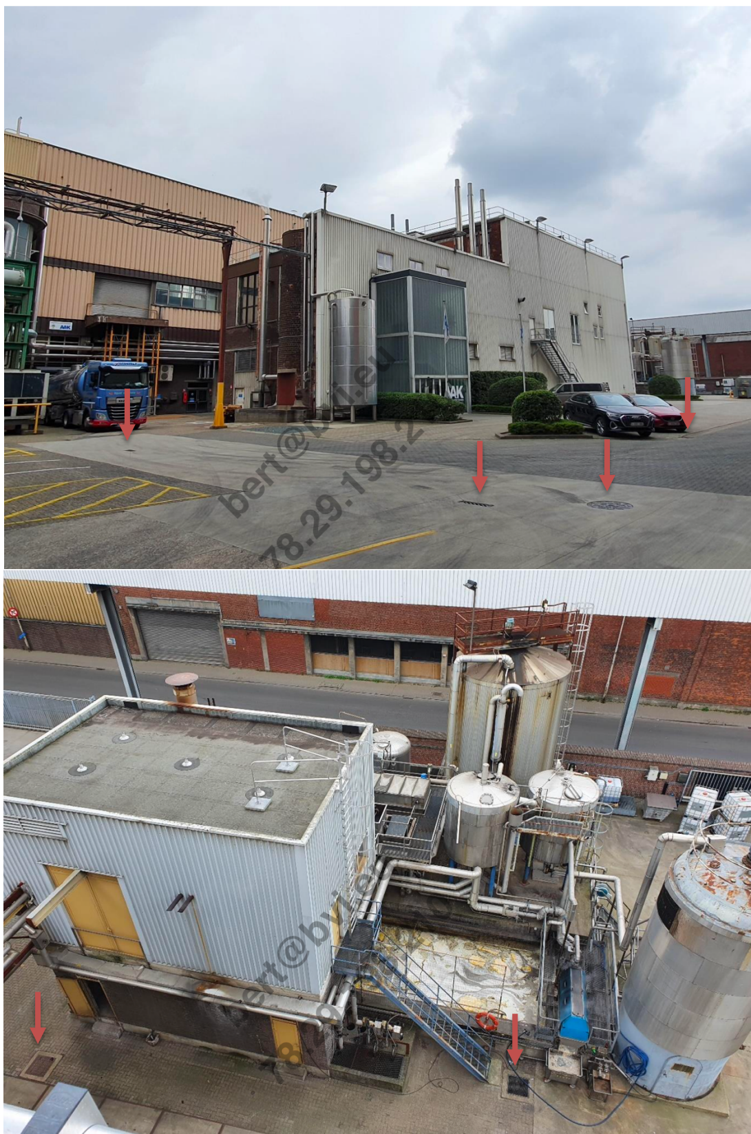
Fig. 1.7: Foto's waarop riolering en putten zichtbaar zijn (aangeduid met rode pijl). 9
