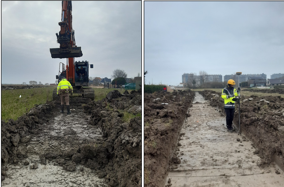
Figuur 4: Foto's methodiek (links: CTE-scanning; rechts: opmeting met GPS)
