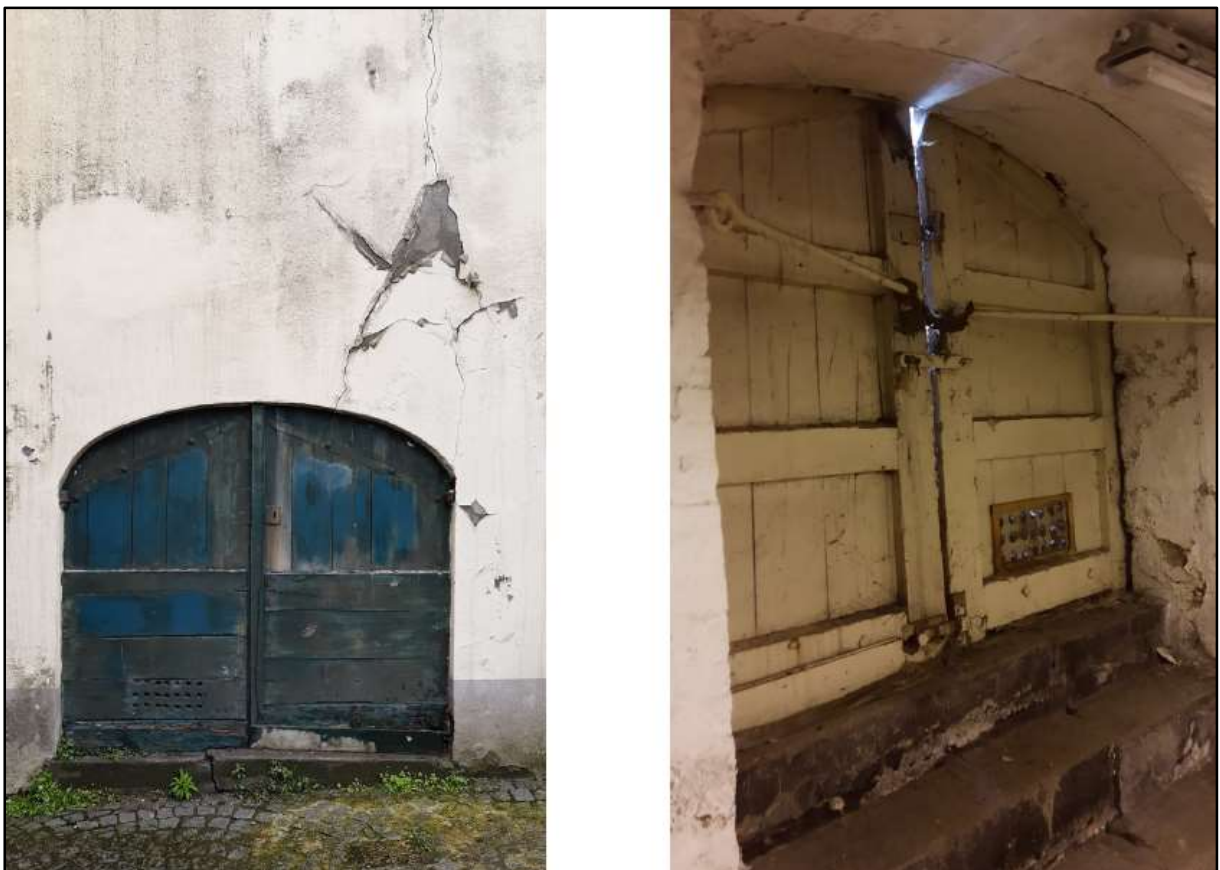
Figuur 6 De getoogde poort in het zuidelijke deel van de achtergevel, die toegang geeft tot de historische kelders, voor- en achterzijde (bron: 360 ARCHITECTEN, 2024).
