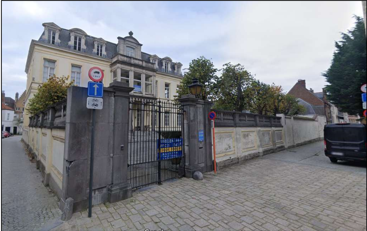
Figuur 2 Zicht op het plangebied, met links de Koningstraat en rechts de Hoornstraat (bron: https://www.google.com/maps/ ).
