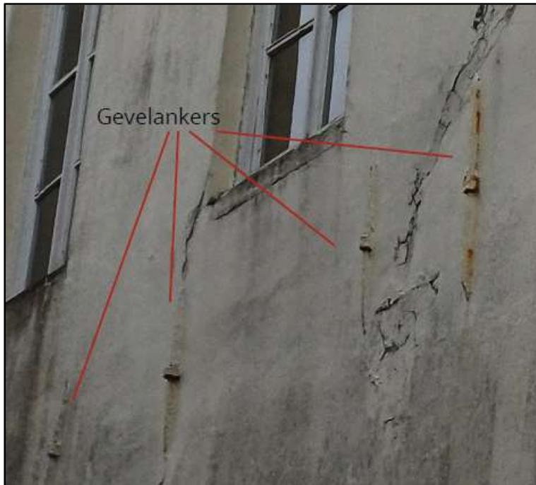
Figuur 5 Detail van de onregelmatige plaatsing van muurankers in het zuidelijke deel van de achtergevel (bron: SERVAYEG & BERGER, 2024).
