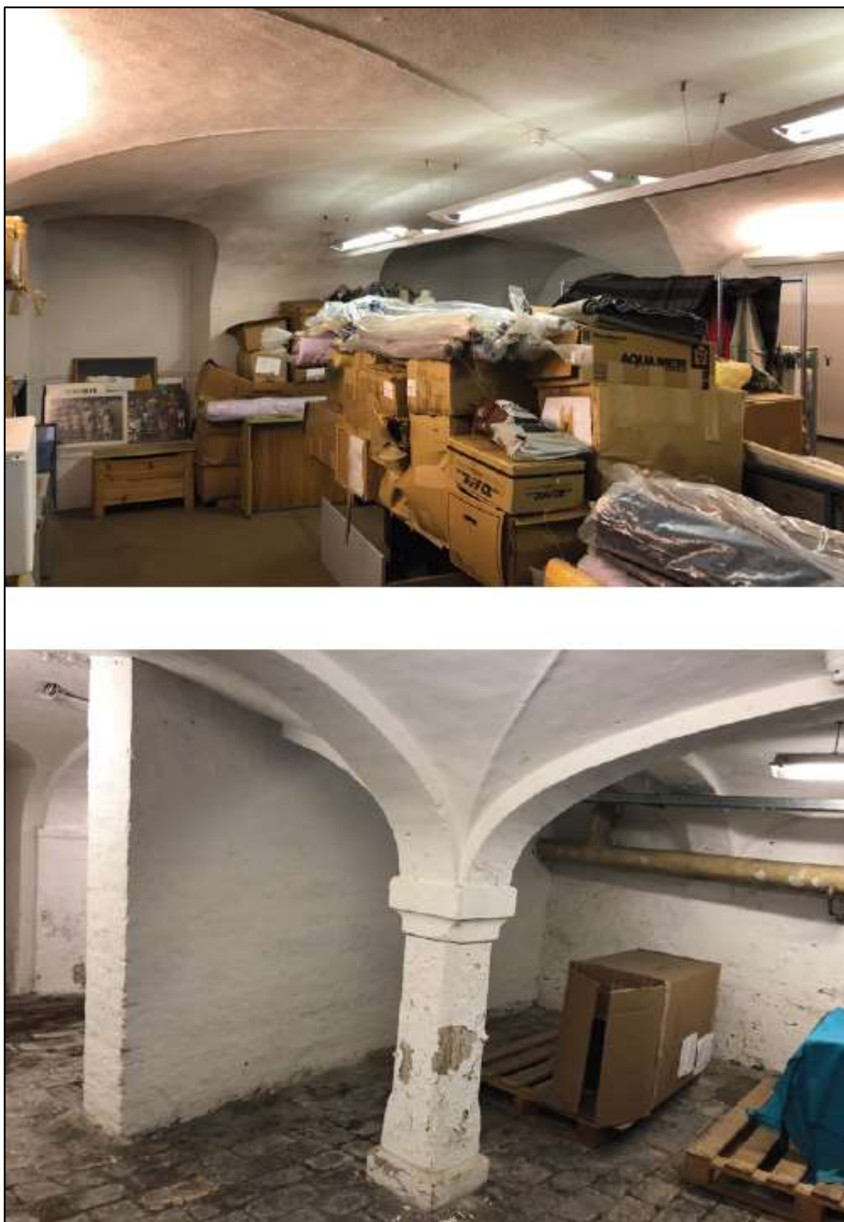
Figuur 8 Enkele binnenaanzichten van de oude kelders (bron: 360 ARCHITECTEN, 2022).
