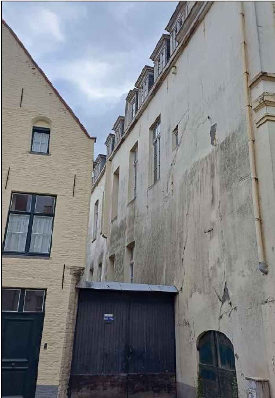
Figuur 4 Zicht op de achtergevel van het Hotel Ruzette, met atypische opbouw van het zuidelijke deel van deze gevel met het onregelmatig gebruik van muurankers, het ontbreken van gevelopeningen en de getoogde poort (bron: SERVAYEG & BERGER, 2024).
