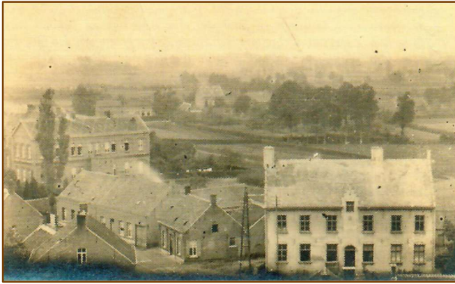
Figuur 24: De Latijnse school of Huis Rome ca. 1915, zwaar beschadigd tijdens WOII en ingestort in 1951. De school is het grote gebouw rechts op de foto (bron: Jubileumboek Brecht 2005, p. 16).
