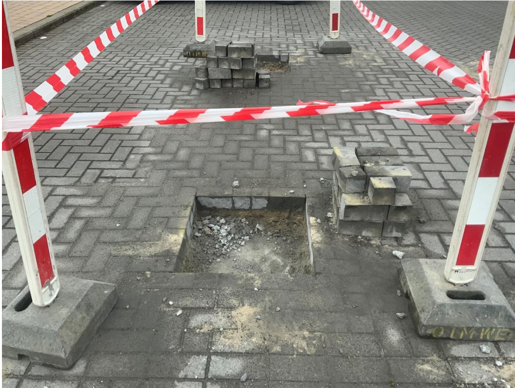
Figuur 20: Detail van originele locatie van boring 11, waar de betonplaat van de ingekokerde beek werd aangetroffen.
